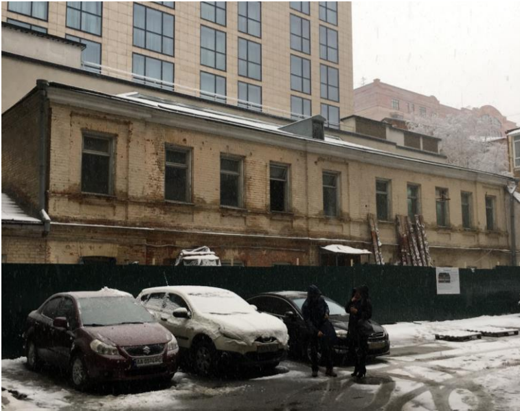
Рис. 1. Вигляд будівлі до реконструкції
