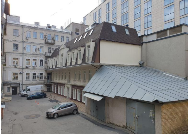
Рис. 4. Вигляд будівлі після реконструкції
