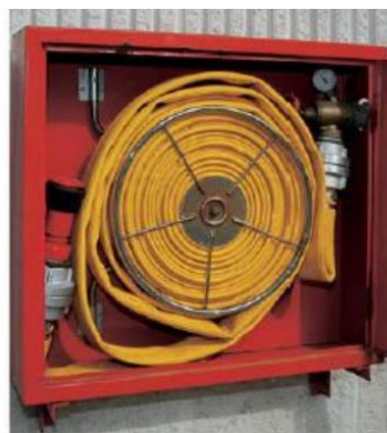
Figura 2.14 - Boca tipo teatro para rede húmida de segunda intervenção (Rodrigues et al. 2005).
