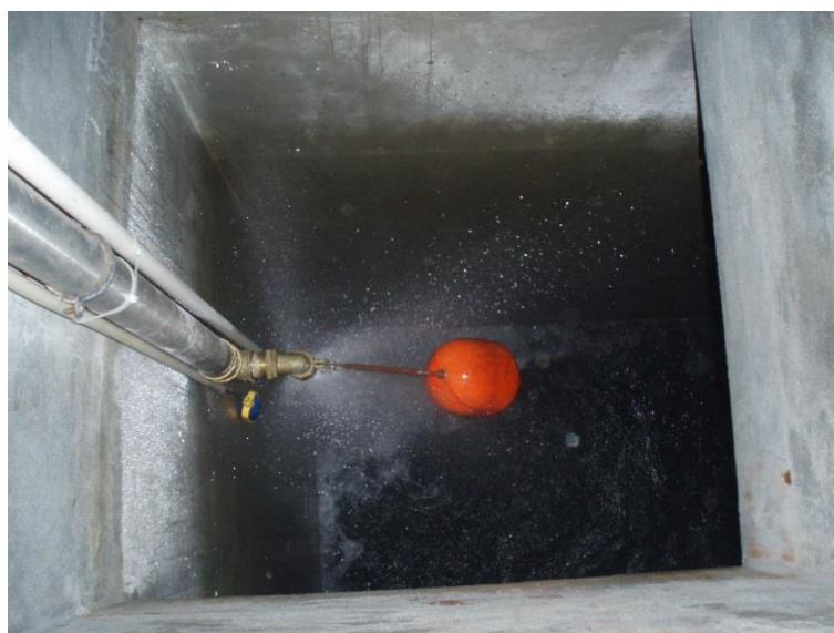
Figura 4.13 – Reservatório em enchimento.
