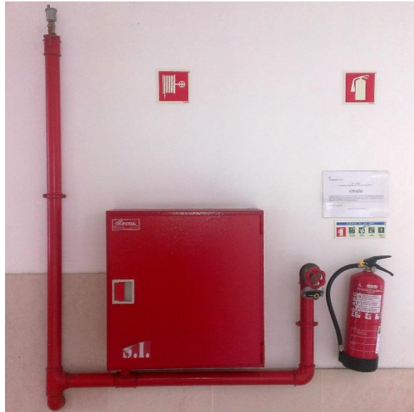
Figura 2.13 – Carretel de primeira intervenção com boca tipo storz para segunda intervenção e válvula de purga de ar (foto do Departamento de Engenharia Civil da FC/TUC, 2014).
