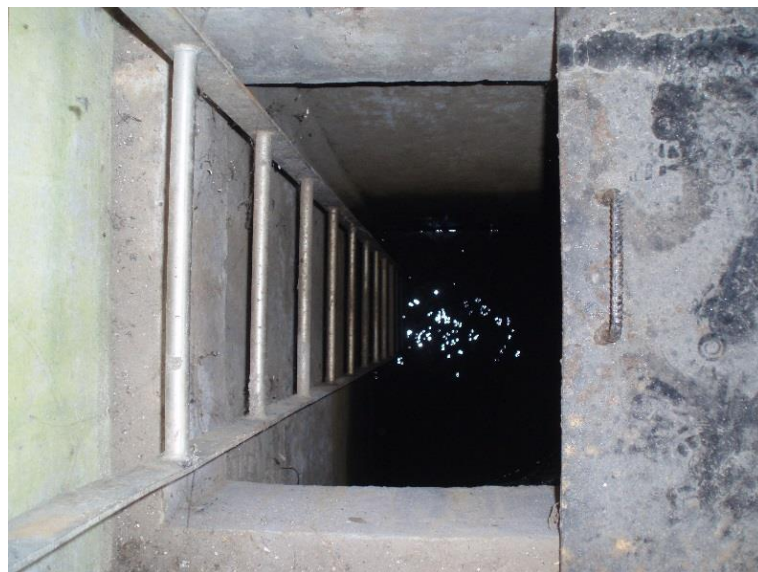
Figura 4.32 – Reservatório de água secundário abastecido diretamente pelo rio.
