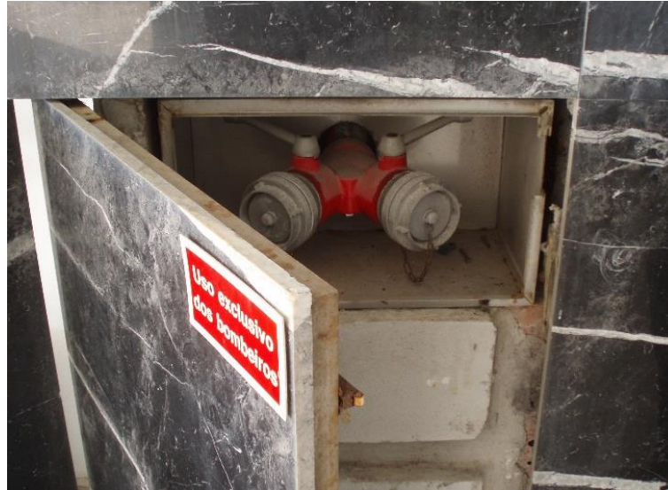
Figura 4.6 – Boca de alimentação alternativa tipo storz para ligação à rede de combate a incêndios.
