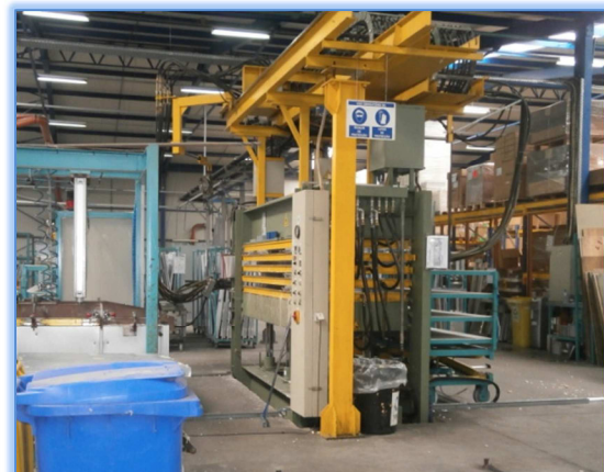
Figura 16 - Secção de calafetagem/injeção - prensa
