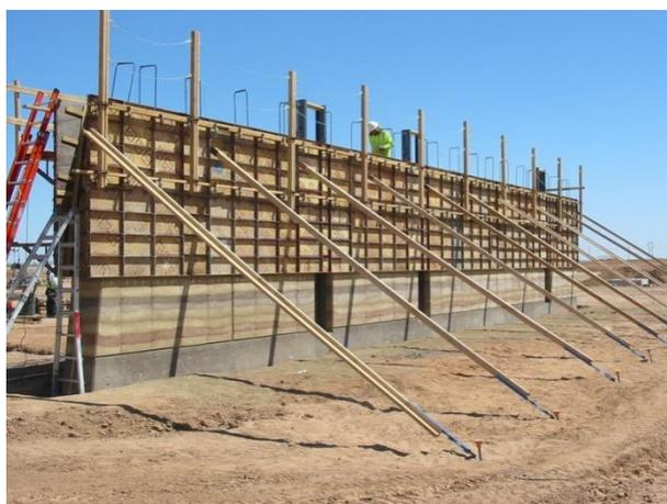
Figura 9 - Parede em taipa em processo de construção [17]
