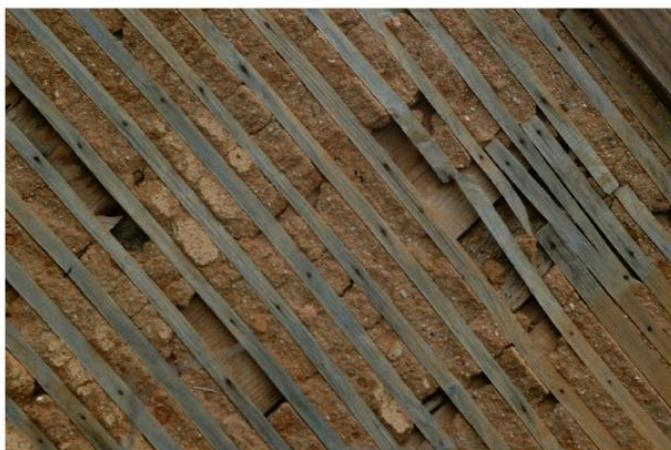
Figura 8 - Parede em tabique [15]
