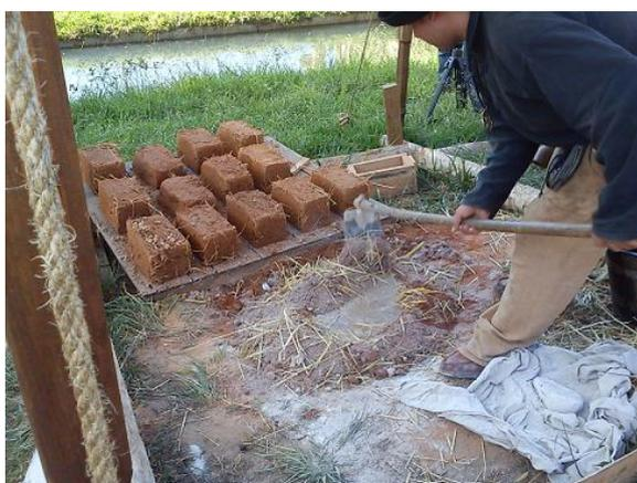
Figura 6 - Procedimento da mistura da terra com cal, água e palha para fabrico dos blocos de adobe
