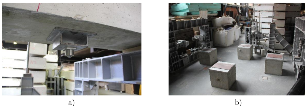
Figura 26 - Ligações dos apoios: a) Esfera de aço; b) Blocos de nivelamento.
