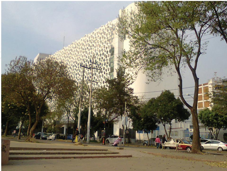
Figure 14. Façade of Torre de Especialidades [51].
