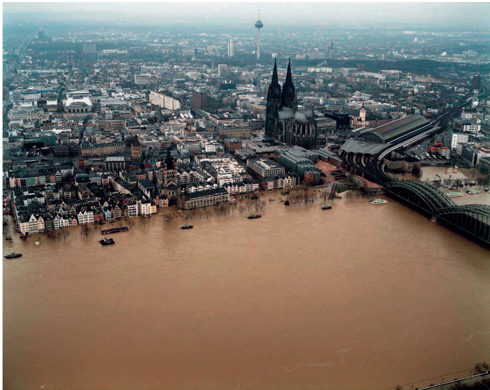
Figure 14. 1995 Flood in Cologne, Germany (source: Stadtentwässerungsbetriebe Köln).
