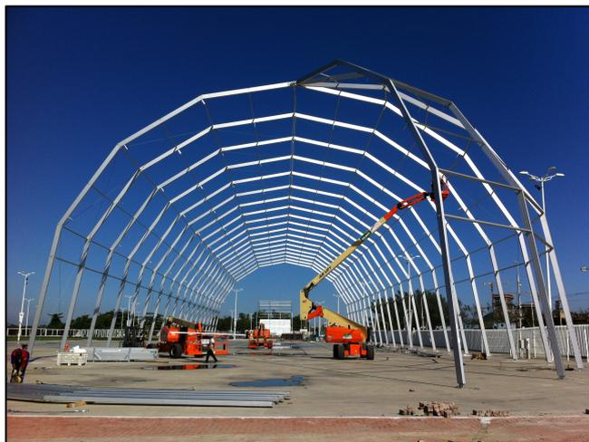
Figura 61: Esqueleto da estrutura com uma das faces semicirculares em montagem.
