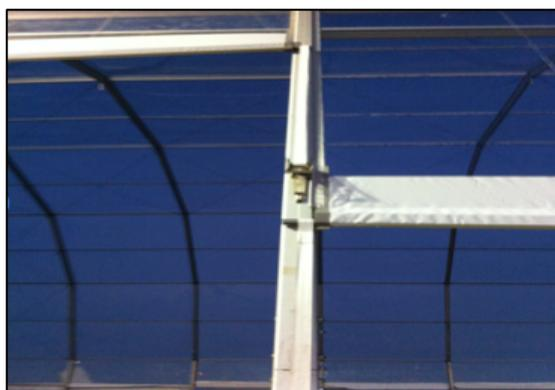
Figura 63: Exemplo de colocação de régua em faces de comprimentos diferentes.
