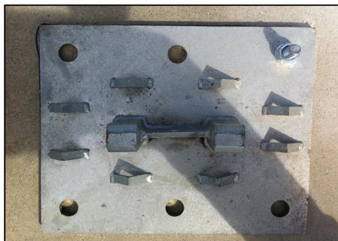
Figura 49: Furação e fixação inicial de uma das sapatas da estrutura.
