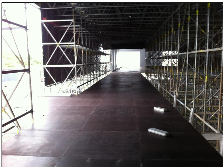
Figura 6: Estrado de acesso às duas áreas técnicas do palco mundo do Rock in Rio, com 2,5 metros de altura.
