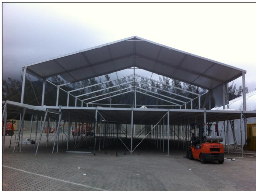
Figura 5: Fase de montagem da tenda catering do Rock in Rio 2013.
