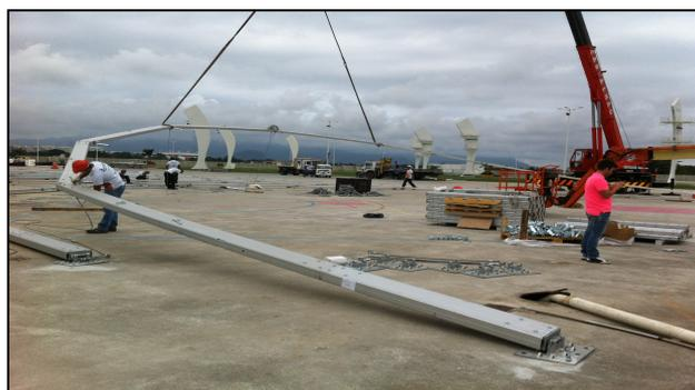
Figura 55: Grua executando o levantamento de um pórtico da tenda.
