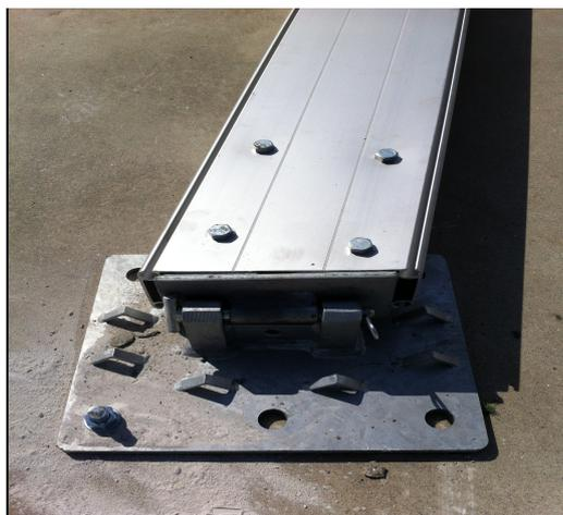
Figura 53: Ligação do pórtico à sapata.
