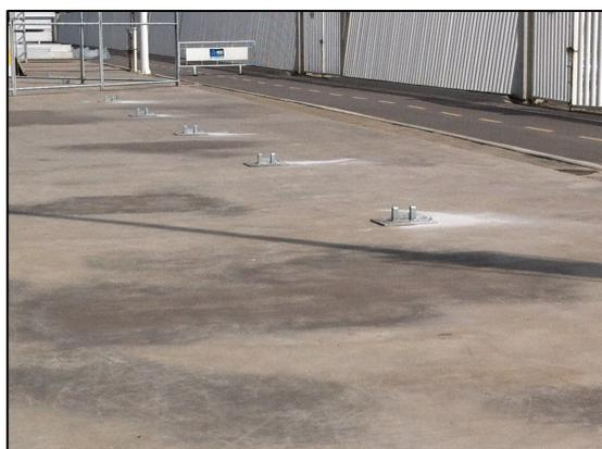
Figura 48: Colocação e alinhamento das sapatas da estrutura.
