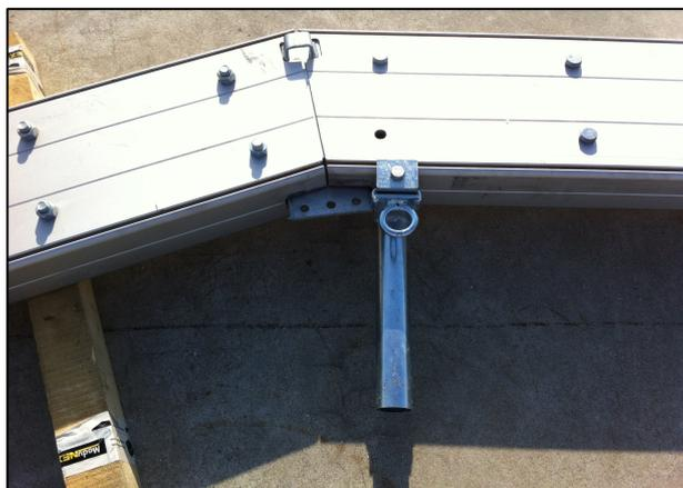
Figura 52: Exemplo de uma união de duas barras, com um dos orifícios livre para aplicação do cabo de aço.
