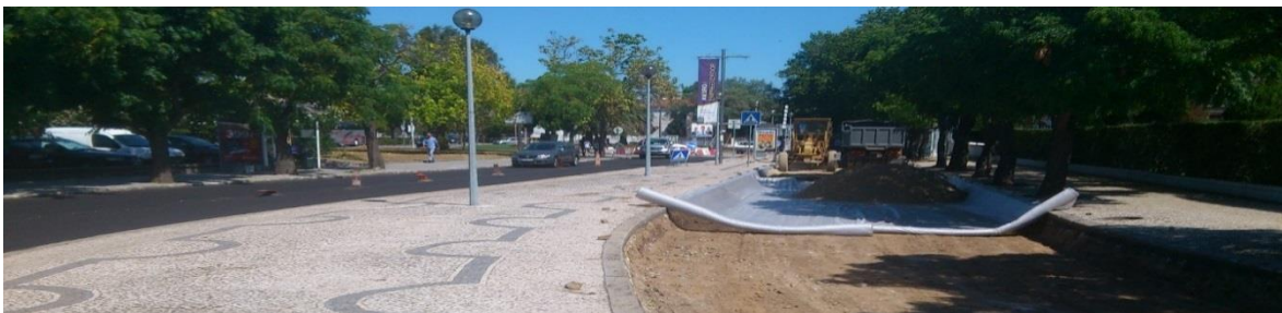
a) Colocação do geotêxtil
