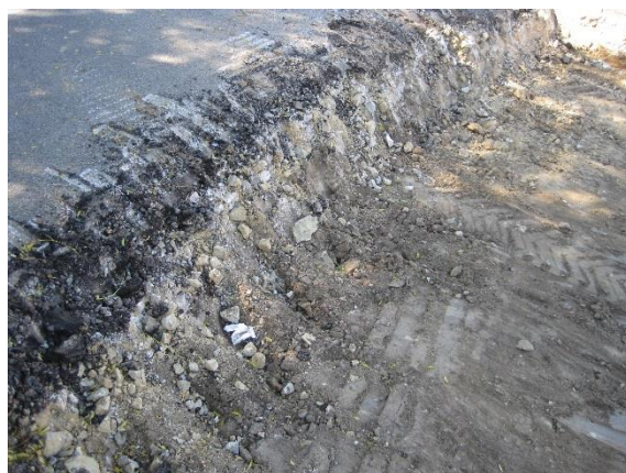
a) Constituição do pavimento existente
