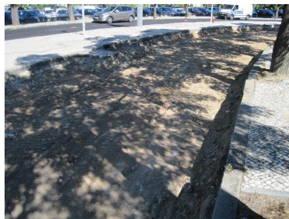
b) Estado da estrada após a escavação
