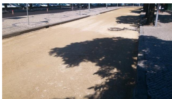
b) Aspetto após a colocação da segunda camada de ABGE
