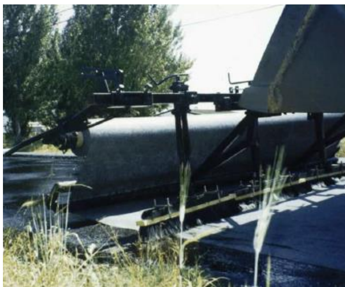
Figura 42: Aplicação do geotêxtil sobre a rega betuminosa (Batista, 2005)
