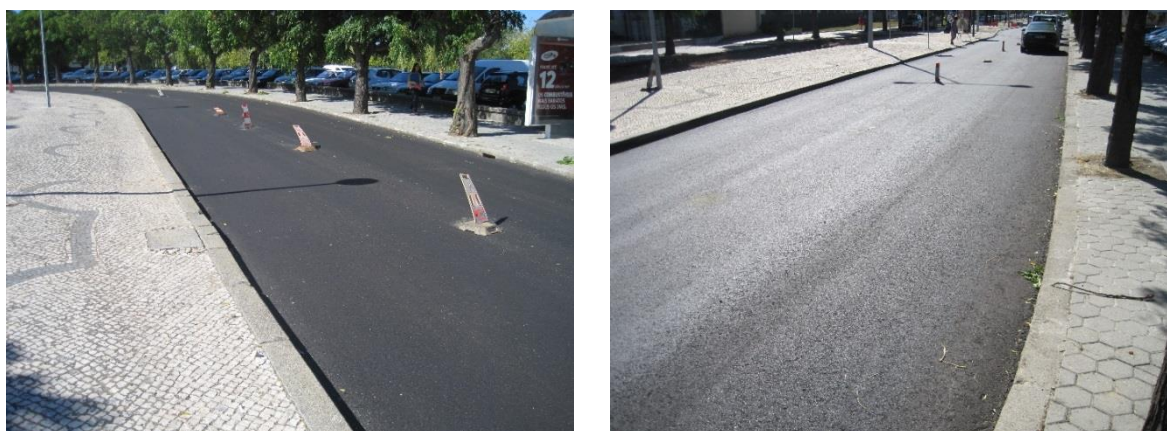
Figura 73: Aspeto após a aplicação do betão betuminoso (fotografias de autor)
