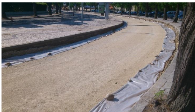
c) Aspetto após a colocação da primeira camada de ABGE
