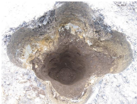
Figura 23: Poço realizado na Avenida da Universidade (fotografia de autor)
