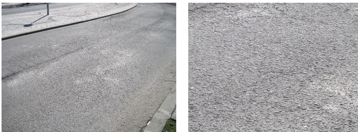
Figura 14: Desagregação superficial e polimento dos agregados na Avenida da Universidade (fotografias de autor)
