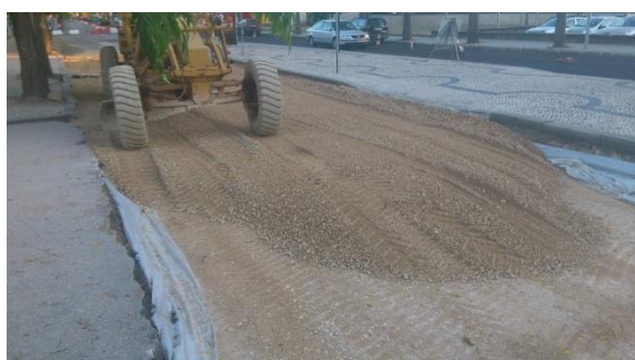
a) Colocação e espalhamento do ABGE
