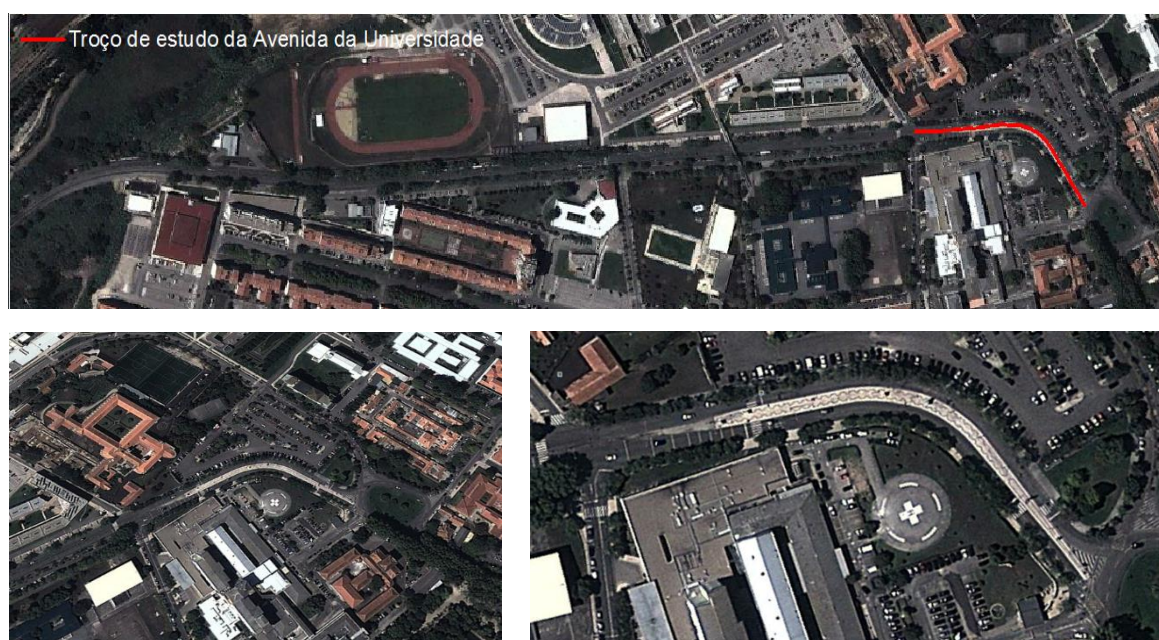
Figura 43: Localização e visualização do troço de estudo da Avenida da Universidade (Retirado de Google Earth, 2013)
