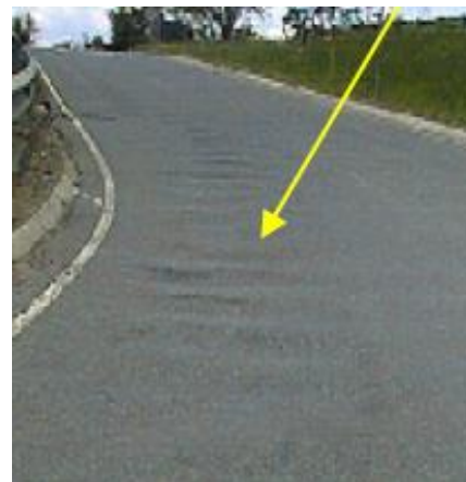
Figura 6: Ondulação (LNEC, 2005)
