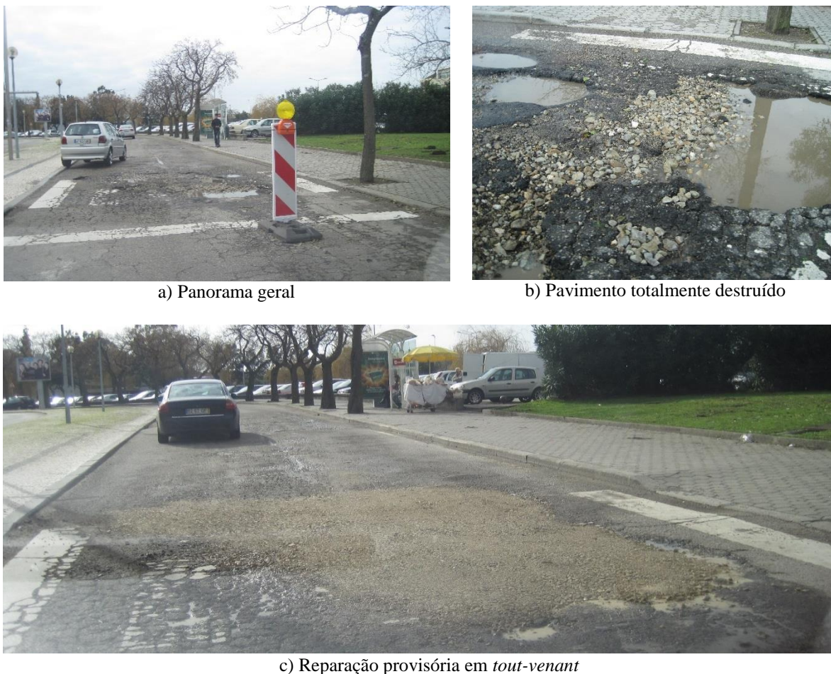
Figura 47: Fotografias do troço em estudo da Universidade de Aveiro captadas durante o Inverno (fotografias de autor)
