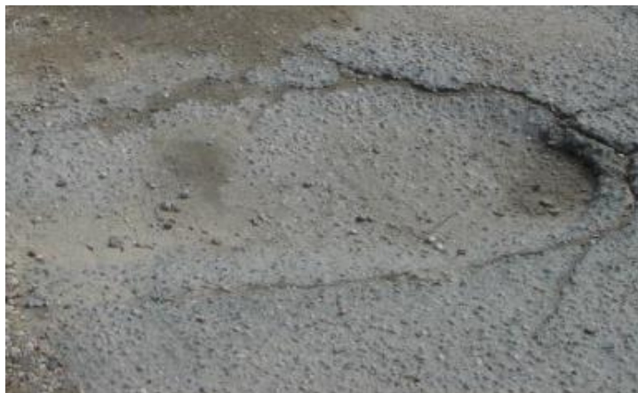
Figura 5: Deformação localizada (Benta, 2012)
