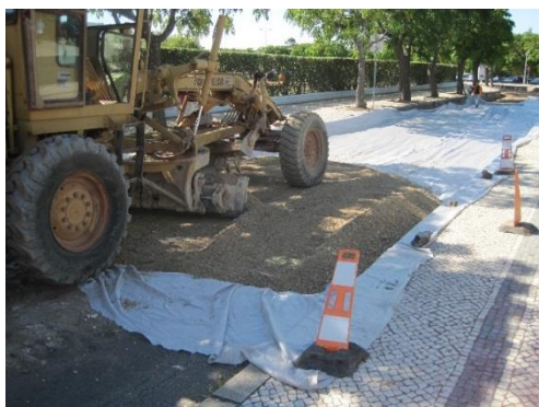
b) Colocação e espalhamento do ABGE
