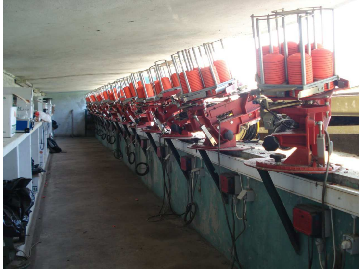
Figura 53: Fosso onde estão localizadas das máquinas de lançamento.
