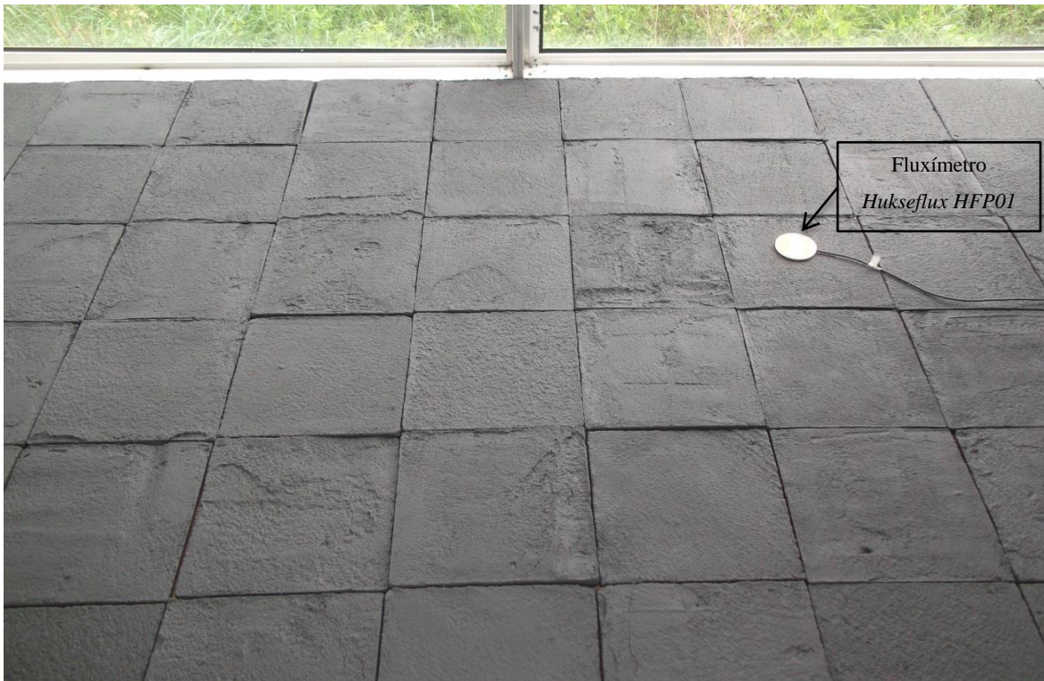
Figura 29 - Colocação do fluxímetro Hukseflux HFP01 sobre o pavimento preenchido de lajetas de argamassa com PCM
