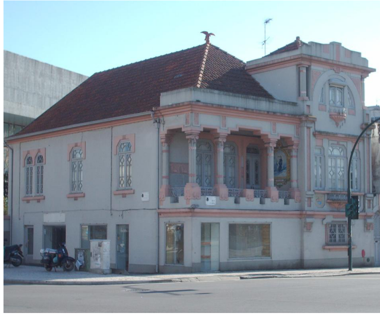
Figura 4: Edifício do projecto ReabilitaDomus
