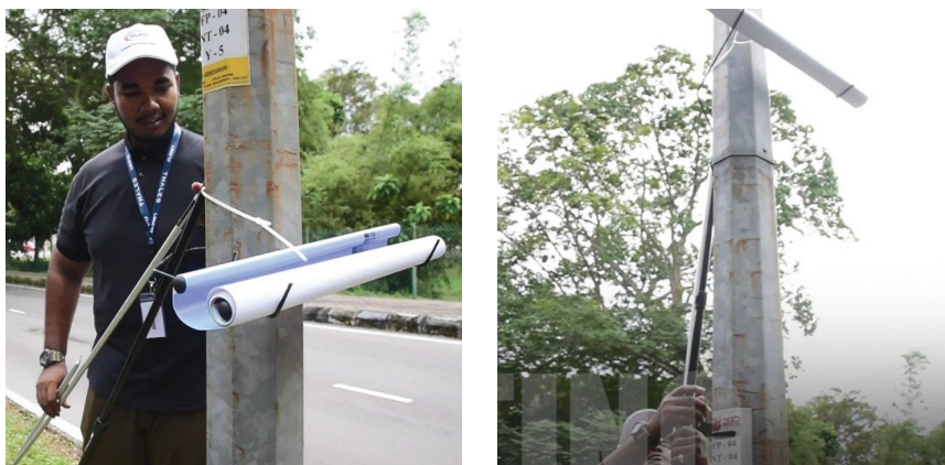
Rajah 9: Kaedah pemasangan gegantung menggunakan inovasi Skytider™
