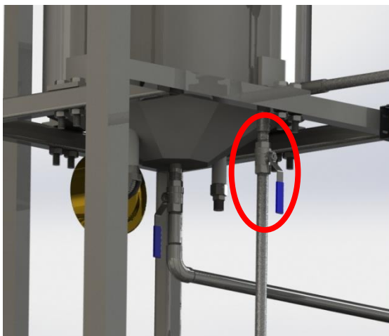
Figura 105. Válvula de descarga del agua del enchaquetado.
