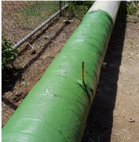
Figura 77. Instalación de los rollos de cobre sobre la tubería de fluido geotérmico.
