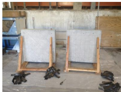
(d) Panels positioned for CFRP application
