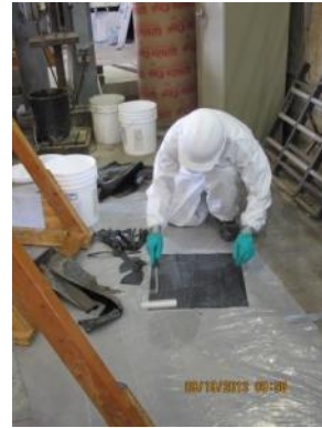
(d) Impregnating CFRP strip
