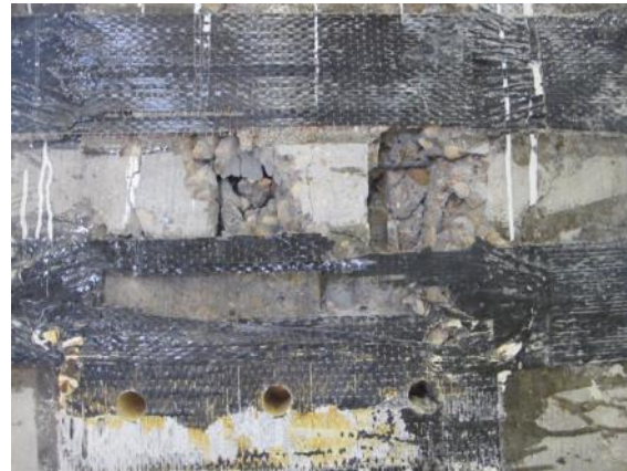
(d) CFRP strip failure of U5-0-2-5
