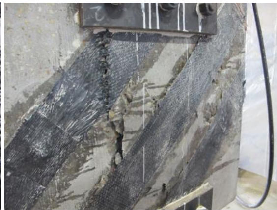
(d) Failure mode of U5-45-2-5
