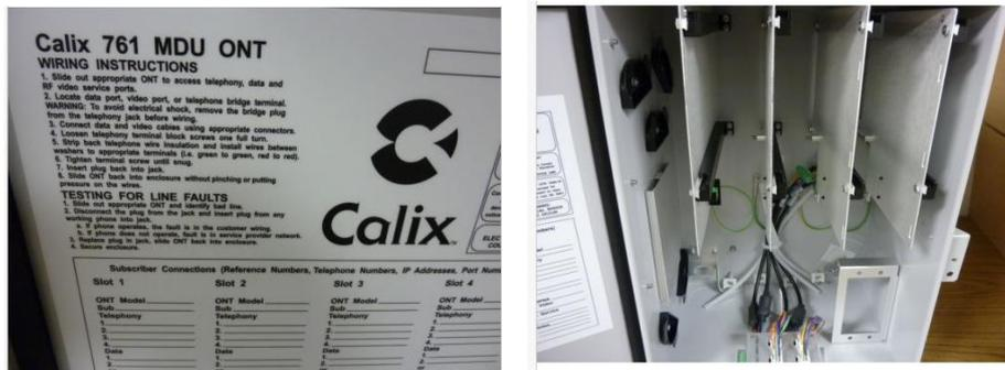
Figura N°40: Caja exterior para almacenaje ONT.<sup>48</sup>
