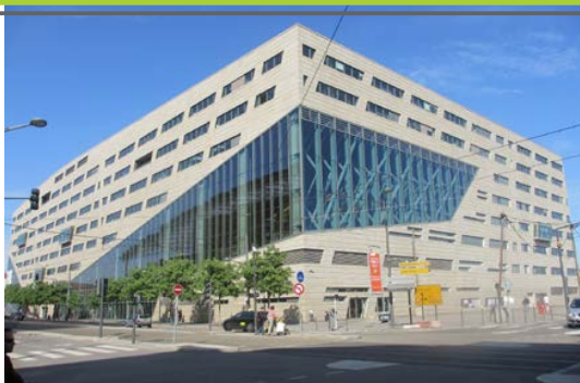
Photo 3. Lyon : le nouveau siège (2011) du Conseil régional Rhône-Alpes dans le quartier central Lyon confluence.
