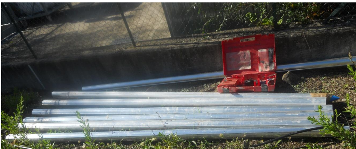
Fig. 26 – Tubo inclinometrico pronto per essere montato. Alla sua base dovrà essere saldato il filo per l'estensimetro, dopo di che potrà essere calato nel foro.
