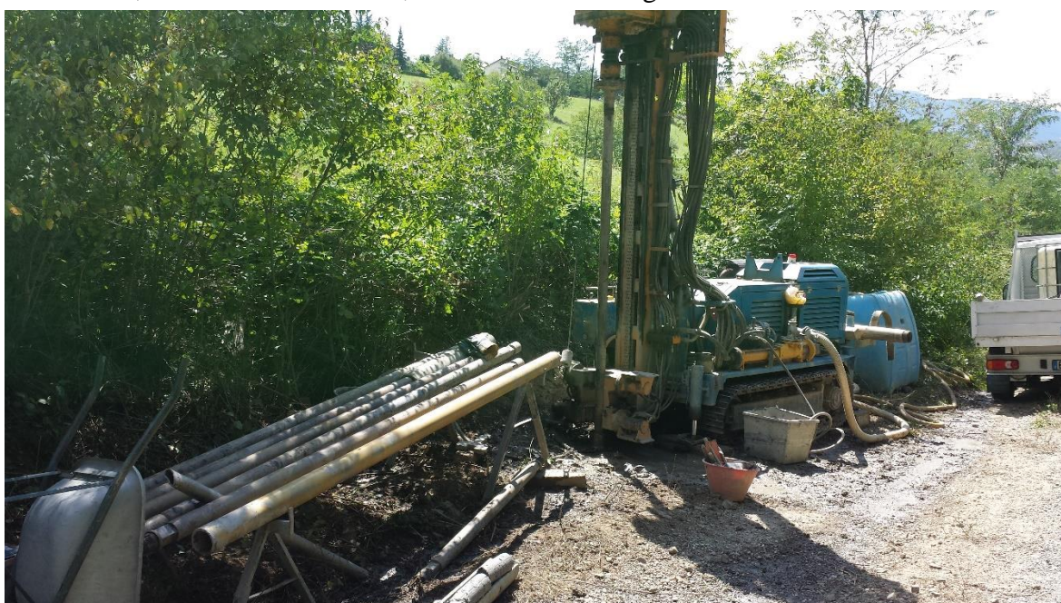
Fig. 22 – Perforatrice idraulica montata su cingoli con cui sono state effettuate le prove. Sulla sinistra è già pronta la batteria di aste.
