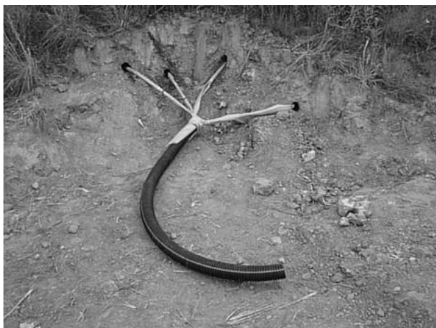
Fig. 13 – Dreni suborizzontali collegati ad un tubo usato per convogliare l'acqua lontano dal versante (da Cook et al., 2008).
