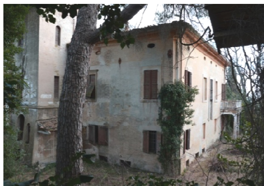
Fig. 11 La villa - fronte< posteriore.
