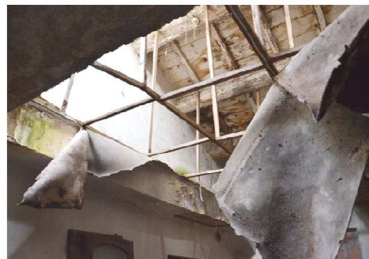
Fig. 83 Particolare del controsoffitto del sottotetto.
