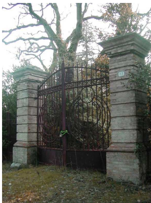
Fig. 99 Cancelli posti all'ingresso principale.
