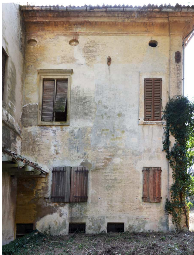
Fig. 40 Porzione del prospetto nord, unico punto di accesso esterno al piano seminterrato. Nella foto in basso a sinistra.
