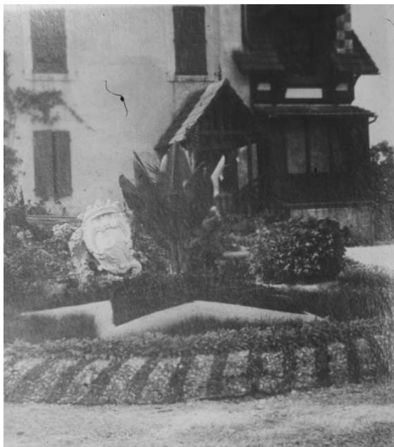
Fig. 27 Struttura lignea laterale in stile tirolese, visibile sulla destra.
