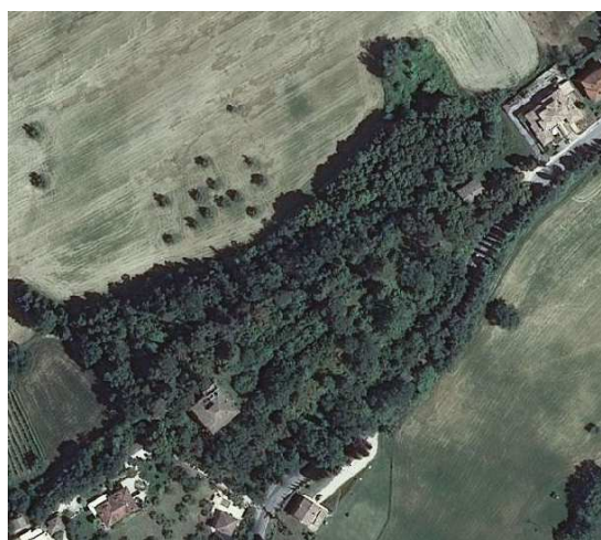
Fig. 57 Immagine aerea, anno 2006. Si nota il parziale crollo della copertura.
