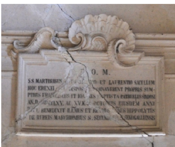
Fig. 80 Cornice posta al di sopra dell'ingresso.
