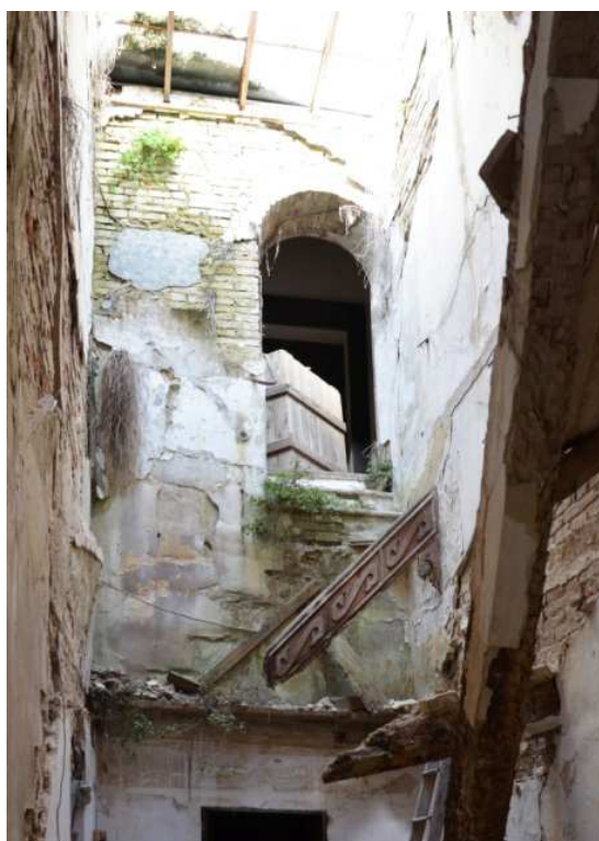
Fig. 117 Vano contenente la scala SC03. Si può notare la rampa inclinata che permetteva di raggiungere l'ultimo piano sfalsato della torre.
