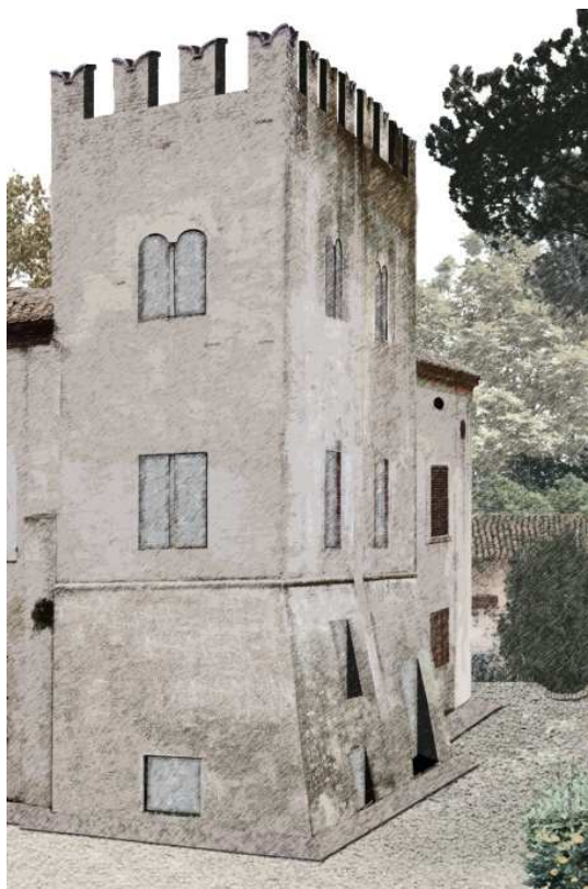
Fig. 119 Vista della torre: in basso a destra è visibile la nuova uscita di sicurezza.
