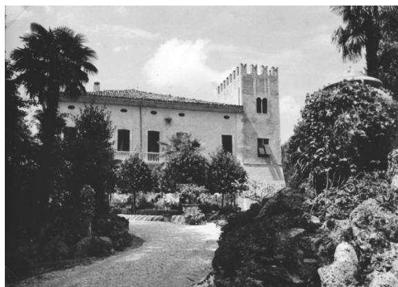
Fig. 28 Foto del 1939 scattata da Mario Carafòli. Si nota la torre laterale merlata, ottenuta sopraelevando quella precedente in stile tirolese. Il balcone centrale è stato ampliato.
