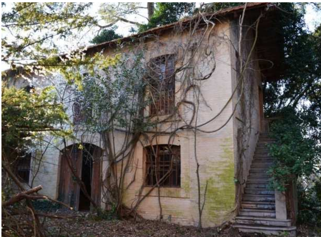
Fig. 86 Limonaia, prospetto sud, anno 2015.
