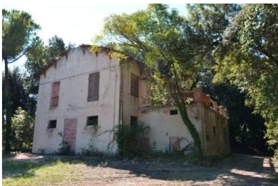
Fig. 82 Vista Nord - Est.
