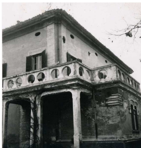
Fig. 29 Ampliamento della cantina.
