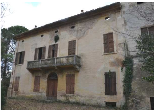
Fig. 12 La villa - Fronte anteriore.
