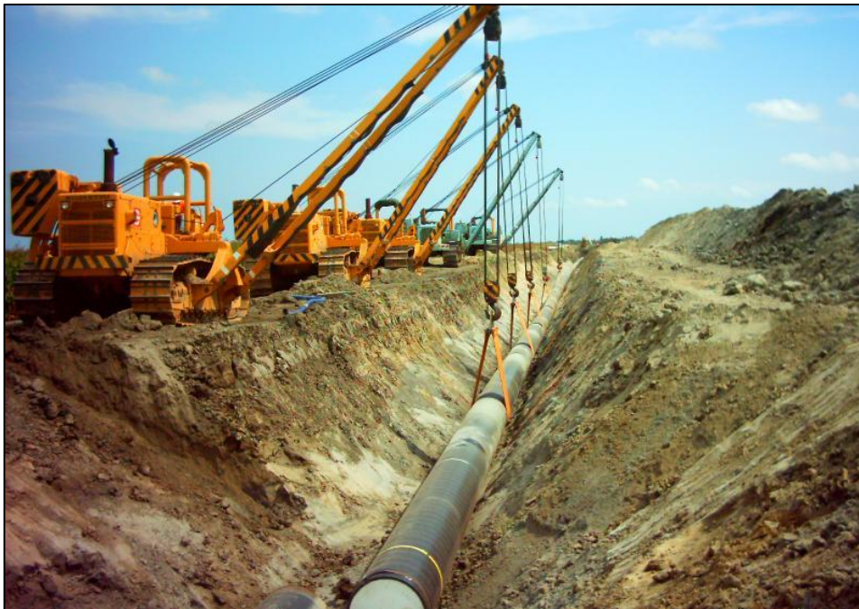
Figura 2.1: Messa in opera di una condotta onshore destinata al trasporto di idrocarburi.
