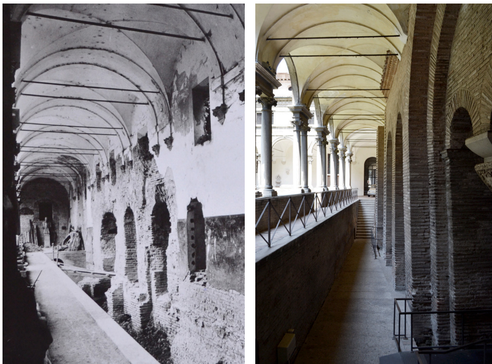
Fig. 12. Lavori di isolamento della facciata del nartece dal muro interno del lato est del secondo chiostro. (Fotografia dei primi anni del Novecento).
