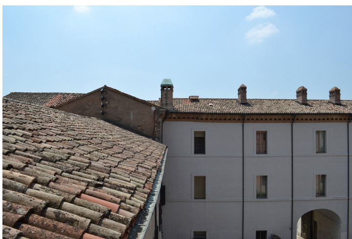
Fig. 2. La copertura degli uffici della Soprintendenza dove, come visibile dal dislivello con le altre falde, un tempo era posto un secondo livello di ambienti.
