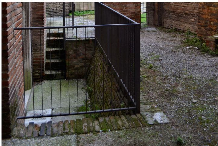
Fig. 2. Scala esterna secondaria utilizzata dal personale di sorveglianza della Basilica.
