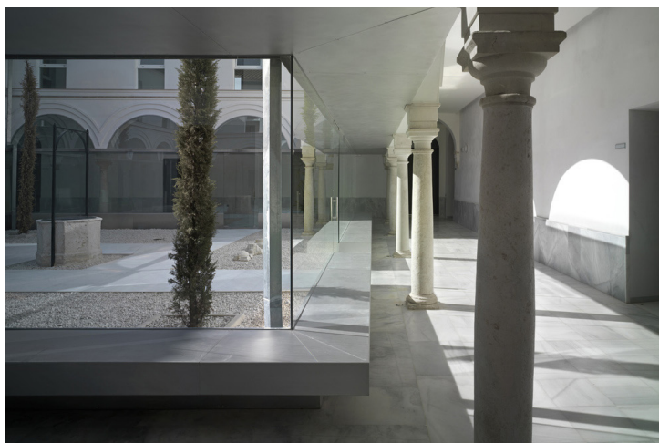
Fig. 1. Nell'ospedale San Jeronimo a Siviglia, realizzato nel 2013 dallo studio SV60 Arquitectos, il chiostro è stato tamponato da una pelle di vetro che amplia il percorso originario e che permette la seduta all'interno di questo nuovo spazio.
