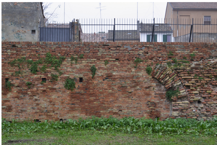
Fig. 2. Le mura lungo il parcheggio accessibile da via di Roma, all'altezza di Porta Serrata. È visibile la traccia di una postierla.
