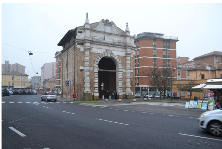
Fig. 11. Il lato esterni di Porta Serrata vista dalla parte nord di via di Roma. La porta risulta completamente isolata, non avendo più edifici o mura ai suoi lati.
