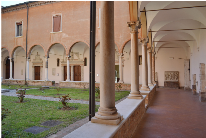
Fig. 1. Primo chiostro detto "chiostro della cisterna".
