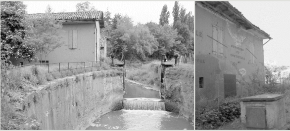
8. Sostegno di Corticella
