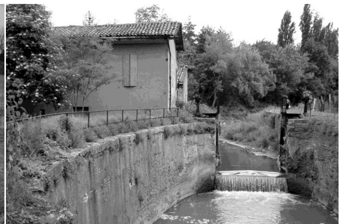
Figura 4.12: Sostegno di Corticella.
