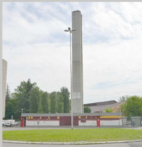
Centrale termica in via Byron
