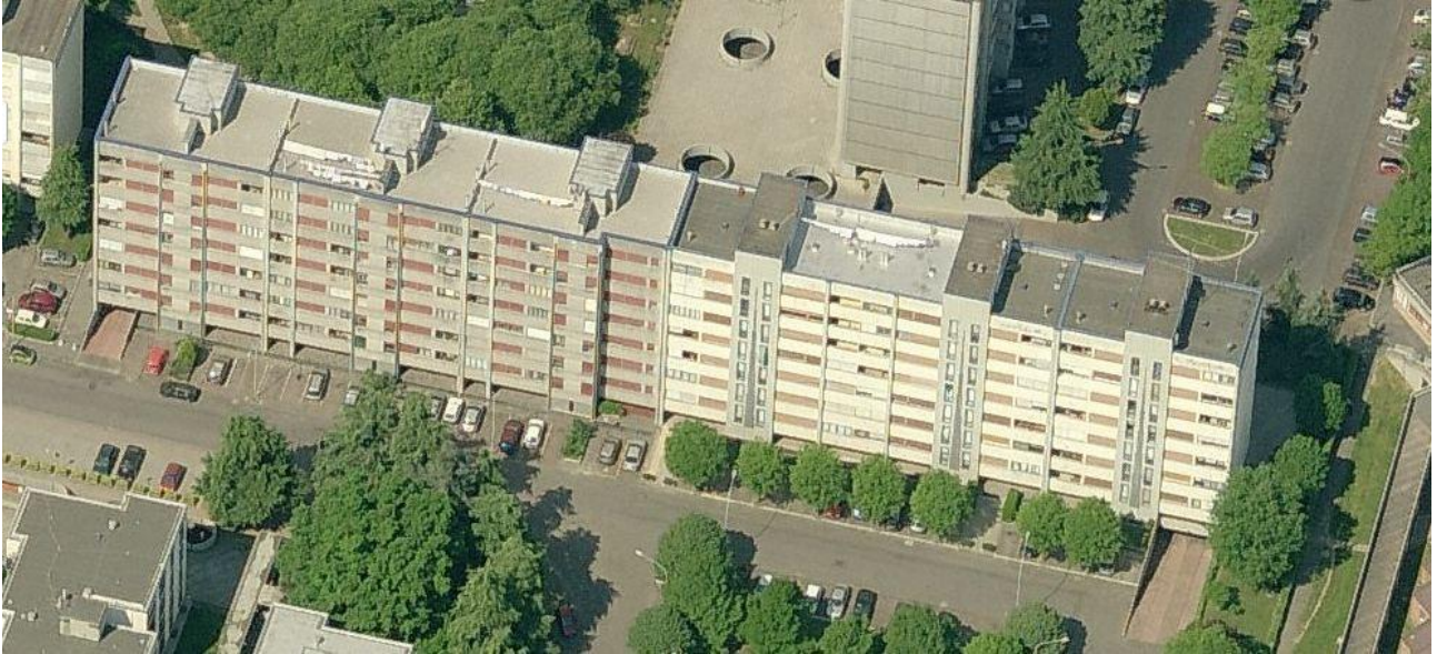
Figura 4.30: Edificio in via Verne dal civico 16 al 26.
