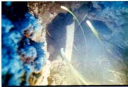
Paroi latérale gauche de P 5
