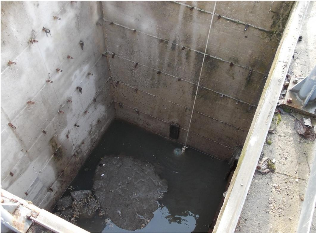
**Fig. 29:** La vasca di accesso al collettore della Zona Industriale. Da notare la massa galleggiante, costituita di componenti grasso-oleose, che si accumula con notevole velocità presso questo sito di campionamento. Al momento dello scatto gran parte del tappo lipidico era appena stato rimosso da un'autobotte aspirante.
