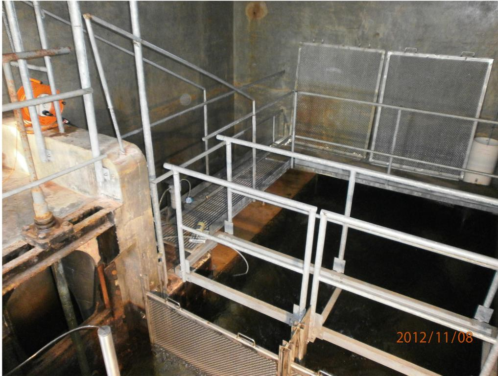
**Fig. 22:** L'interno del Partitore di Vicenza. La vasca che si intravede ripartisce l'acqua della Canaletta tra Padova ed uno scarico laterale, che in origine avrebbe dovuto consentire anche l'approvvigionamento idrico della città berica.
