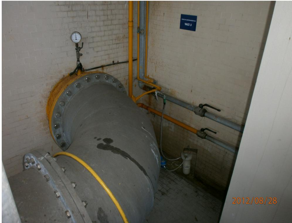
**Fig. 24:** L'ultimo sito di campionamento accessibile prima dell'immissione dell'acqua nella rete di distribuzione cittadina vera e propria. In figura è visibile il rubinetto da cui si effettua il prelievo: si tratta dello stesso snodo utilizzato anche per controlli sanitari.
