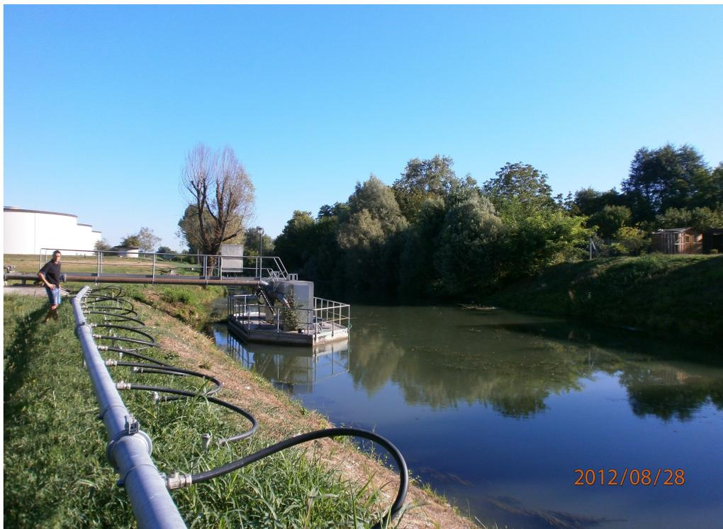
**Fig. 25:** Il Canale Brentella. Nel perimetro del CIB si trova un impianto ausiliario per la captazione idrica dell'acqua superficiale del canale. Nella foto la piattaforma idrovora e la condotta dei pozzi golenali.
