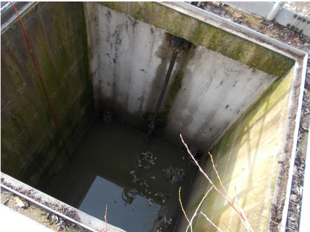
**Fig. 30:** Una vasca verticale, analoga a quella del collettore ZIP, consente di campionare il collettore Fossetta. Poco più a valle delle due vasche i due collettori si riuniscono, subiscono un trattamento preliminare di grigliatura e si dipartono verso il depuratore di Ca' Nordio.
