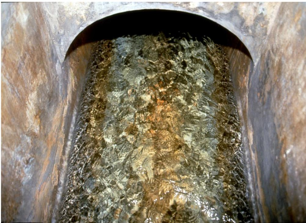
**Fig. 23:** La Canaletta a pelo libero, costruita nel 1890, è ancora oggi in funzione e adduce per gravimetria l'acqua dai pozzi di Villaverla fino al Centro Idrico Brentelle, nella periferia ovest di Padova.
