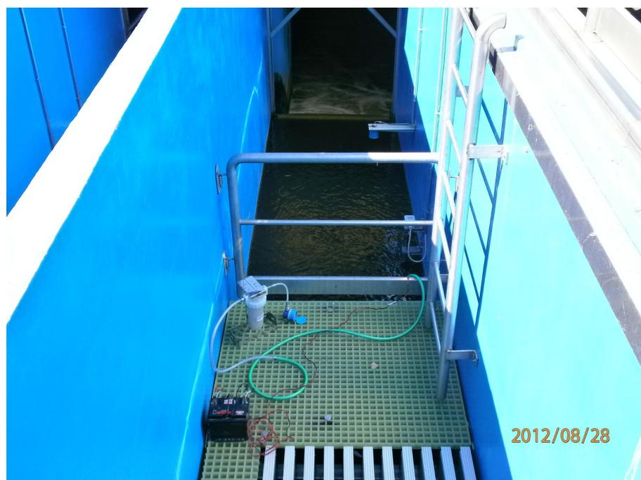
**Fig. 32:** Lo scarico del depuratore fognario di Ca' Nordio. L'impianto si serve di un uscita comune per il refluo trattato. La piattaforma visibile nella foto si trova subito a valle delle lampade UV-C.
