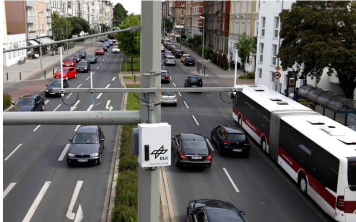
Abbildung 3: Sende- und Empfangseinrichtungen für die Fahrzeug-Infrastruktur-Kommunikation
