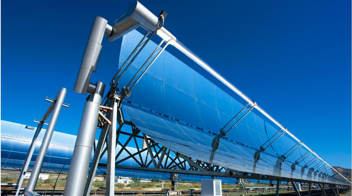
Abbildung 2.4.: Parabolrinnenkollektor auf der PSA [7]
