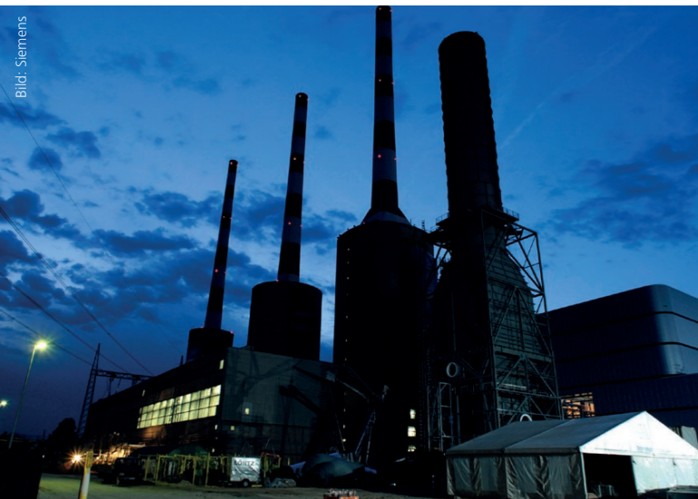
Gaskraftwerk Irsching: Die effizienten Blöcke 4 und 5 des Gaskraftwerks gingen ab 2010 ans Netz, kamen aber aufgrund ihrer hohen Grenzkosten kaum zum Einsatz.
