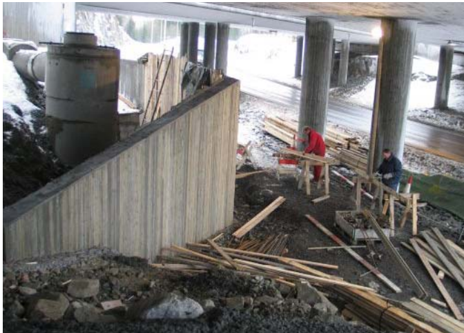
Figur 9: Avforskalt støttemur
