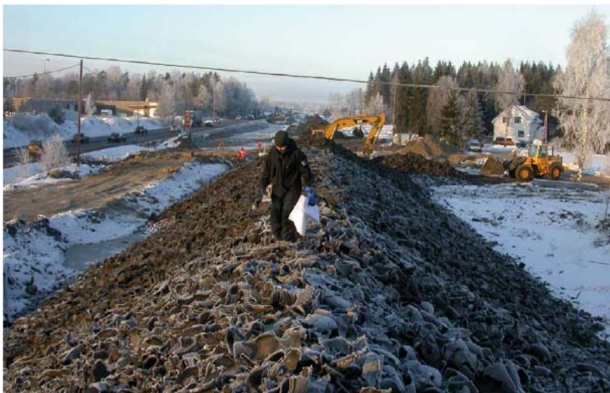
Figur 21: Bygging av støyvollen ved Huggenes
