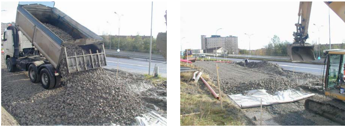
Figur 3: Utlegging av gjenbruksmaterialer
