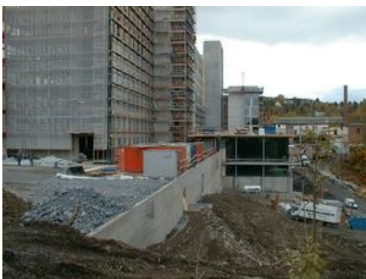
Figur 10: Bygging av Vegdirektoratets bygg på Brynseng
