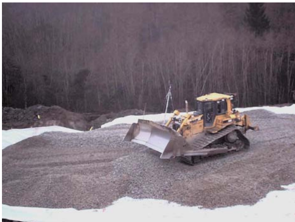
Figur 18: Utlegging, avretting og komprimering
