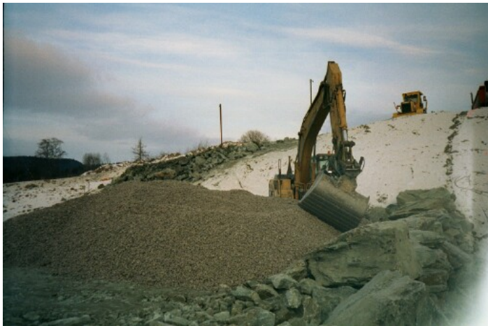
Figur 14: Utlegging av HASOPOR standard med gravemaskin
