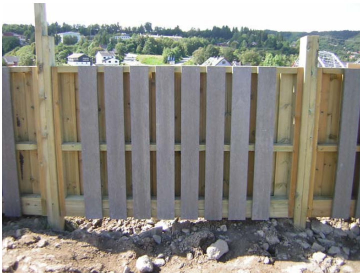
Figur 29: Støyskjerm under oppbygging
