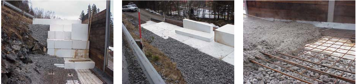
Figur 20: Til venstre vises skumglass lagt mot EPS-fylling, i midten vises skumglass og EPS ovenfra, og til høyre legges det betong på skumglass og EPS
