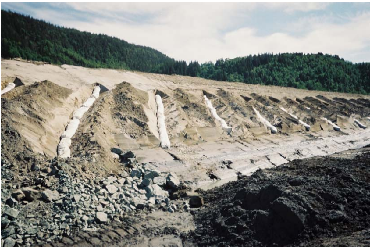
Figur 30: Skumglass pakket i fiberpølser som skråningsdrenering
