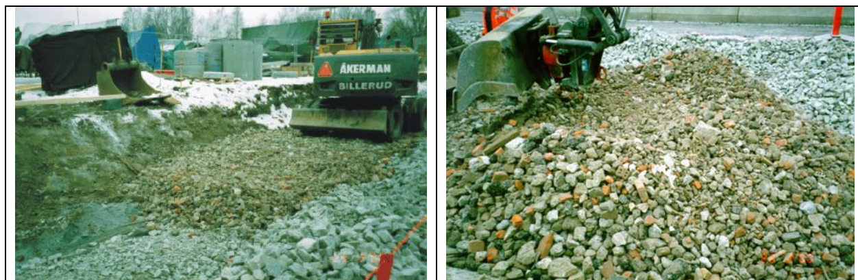
Figur 6: Utlegging av resirkulert tilslag
