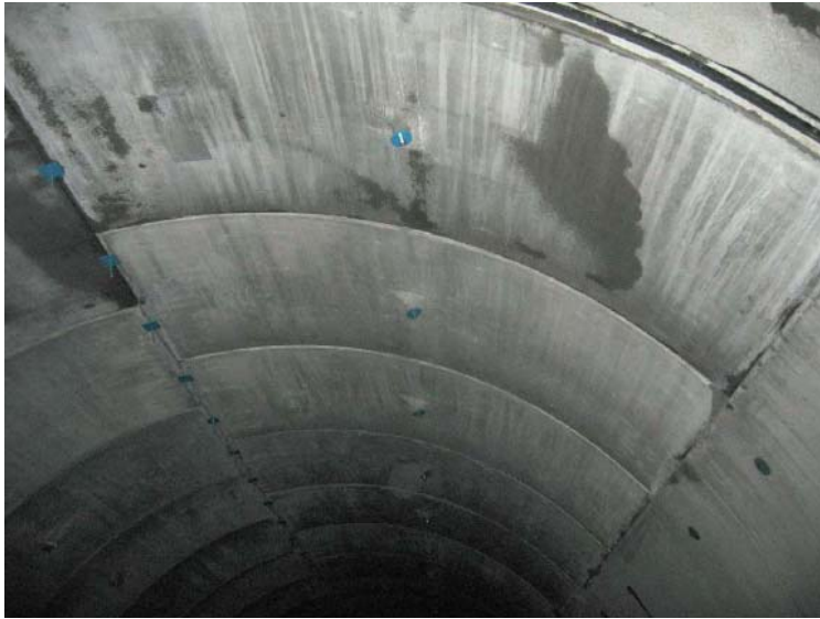
Figur 6 Lettbetongelement i tak
