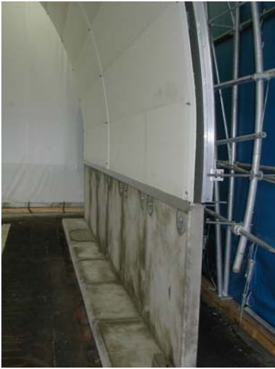
Figur 17 Flexihvelvet i kombinasjon med betongkant
