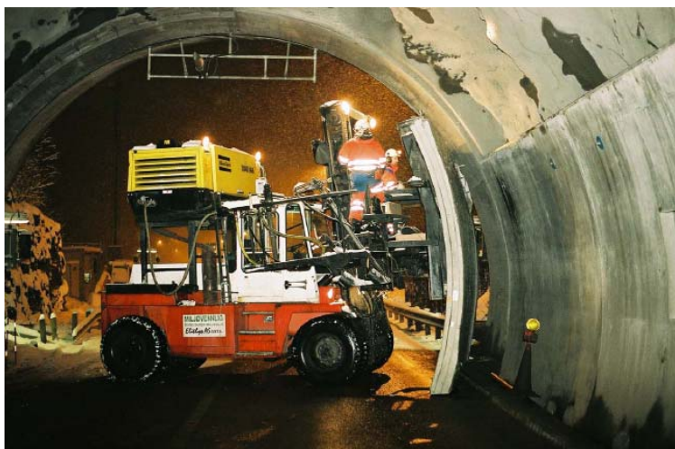
Figur 5 Montering av element
