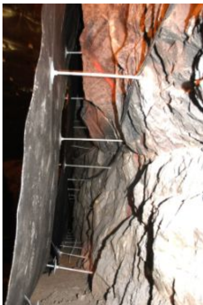
Figur 2 Membran i vannavskjermingssystemet
