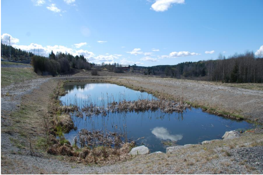
Figur 12. Rensebassenget Taraldrud nord, mai 2010. Slambassenget vises i forgrunnen. Foto: L.S.Heier.
