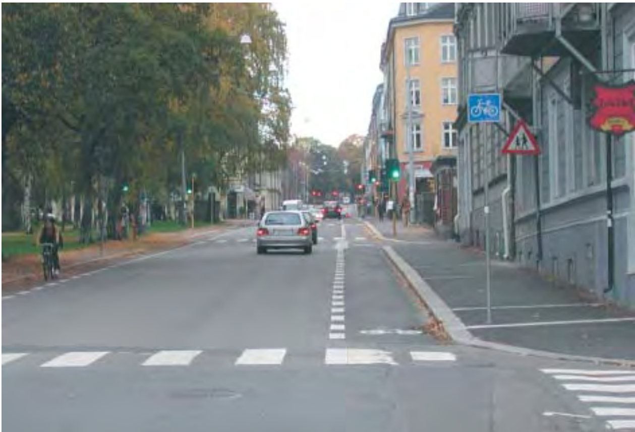
Sykkelfelt er egne kjørefelt i kjørebanelen for sykkeltrafikk. Anlegges som symmetrisk løsning. Sykkelfelt skal iht trafikreglene skiltes med skilt nr 520 Sykkelveg, og merkes med sykkelsymbol.
