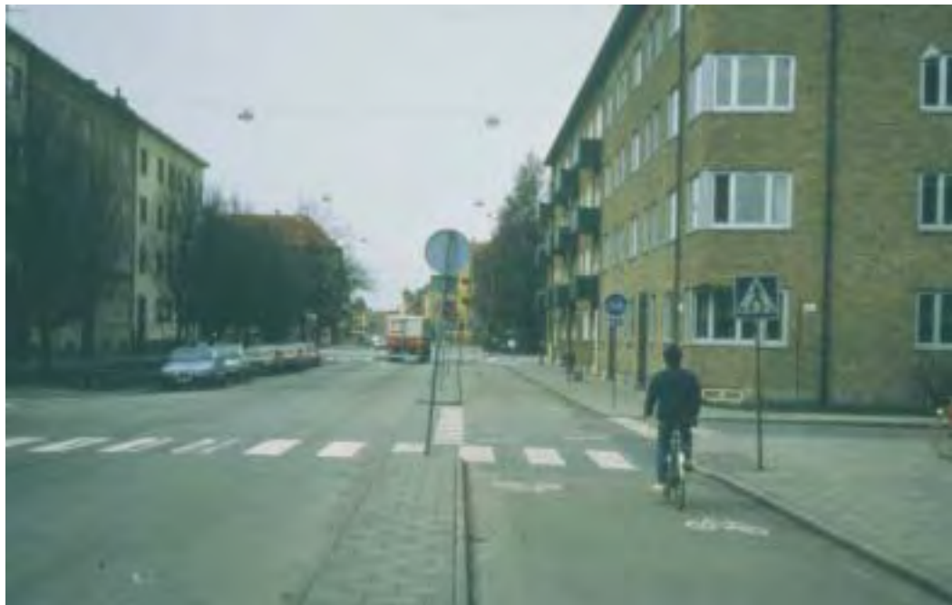
I slike gater har det i Malmö blitt 50% flere ulykker etter at man bygde denne typen løsninger, separat sykkelveg for tovegs trafikk på den ene siden av kjørebanelen.
