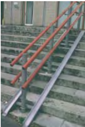
En enkel skinne i ei trapp gjør det enklere å ta med sykkelen.
