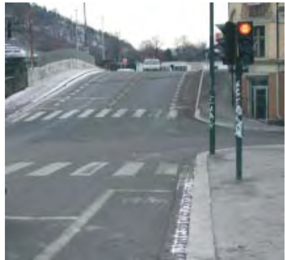
Tilbaketrasket stopplinje for biler i signalregulert kryss.
