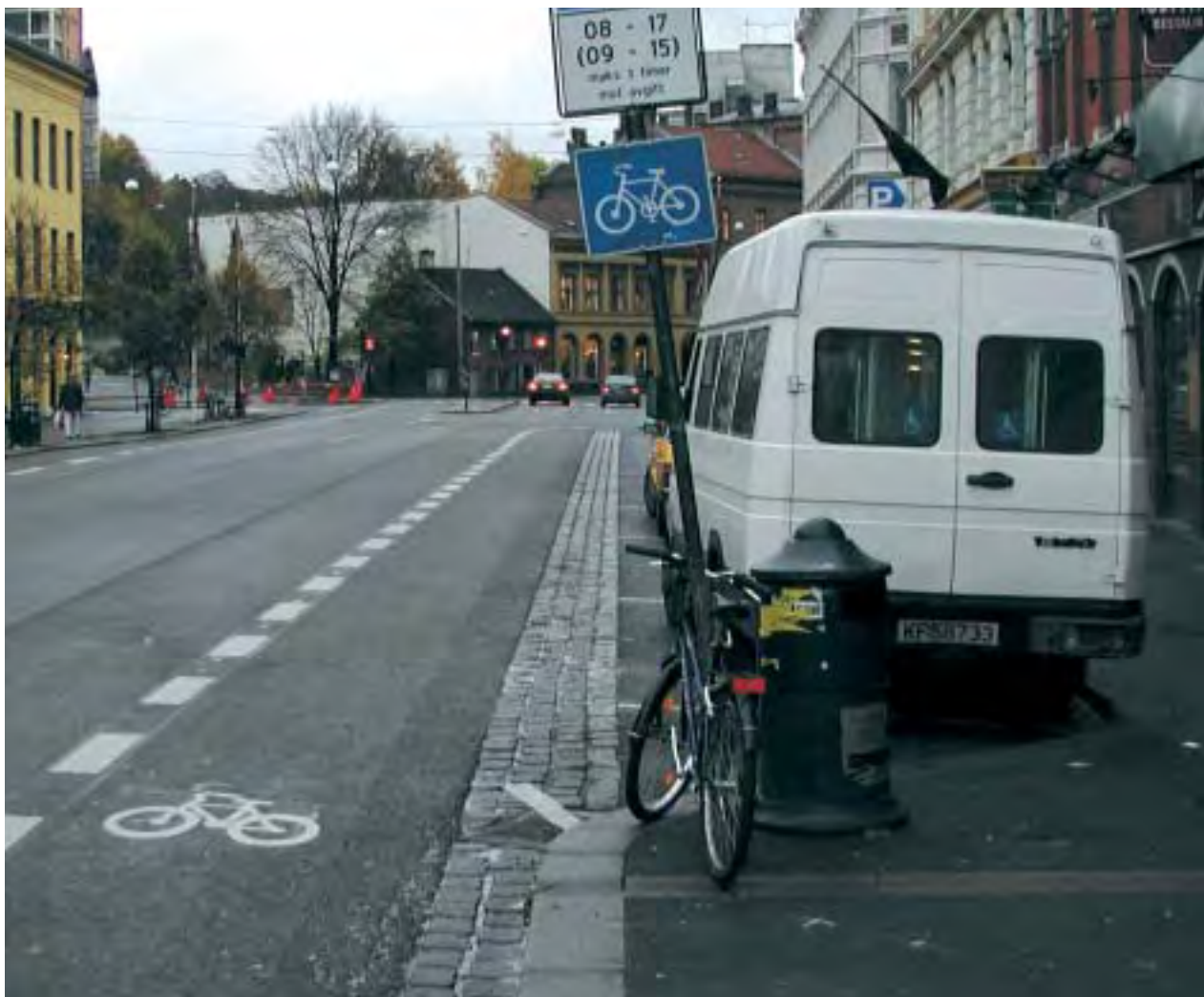
Parkering og varelevering innenfor sykkelfelt. Merk buffersone som sikrer avstand mellom biler og syklister. Grønland, Oslo.
