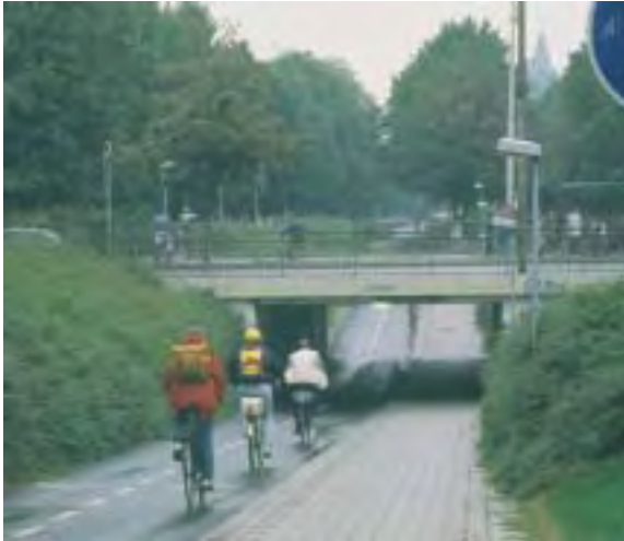
Sykkelveg med fortau krysser under annen veg. Malmö.
