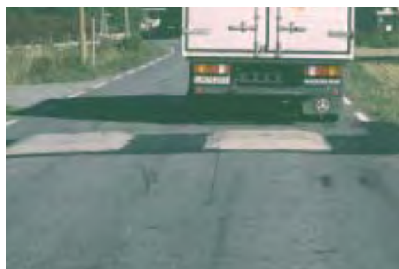
Busshumper/puter hindrer ikke store kjøretøy, men demper hastigheten på personbiler.
