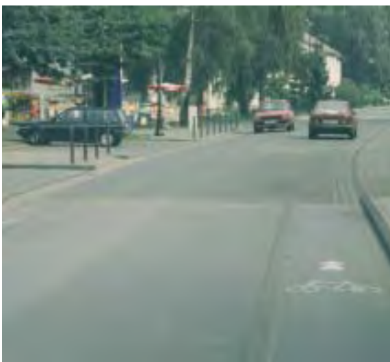
Hump ved avslutning av sykkelfelt på strekning.
