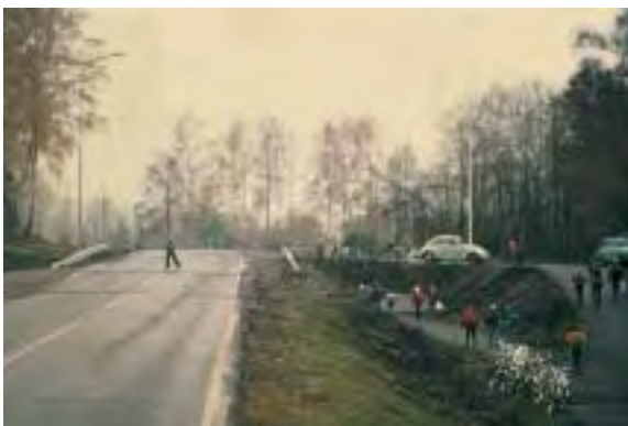
Uheldig utformede underganger fører til lekkasje.
