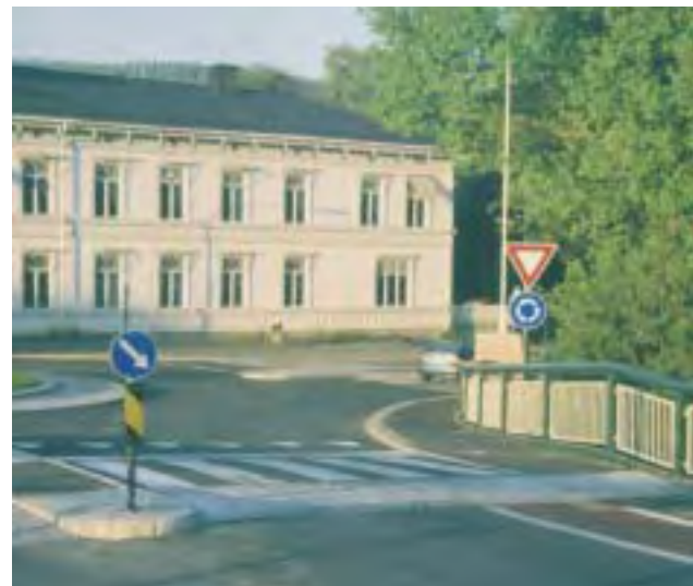
Rundkjøring med sykkelfelt i tilfartene. Sykkelfeltet føres helt fram til opphøyd gangfelt. Landfalløya, Drammen.
