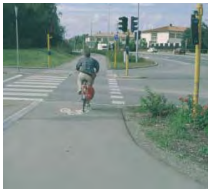
Sykkelveg krysser annen veg i kryss med særskilt signalregulering. Sykkelkryssing anvendes i vikepliktsregulert kryss.
