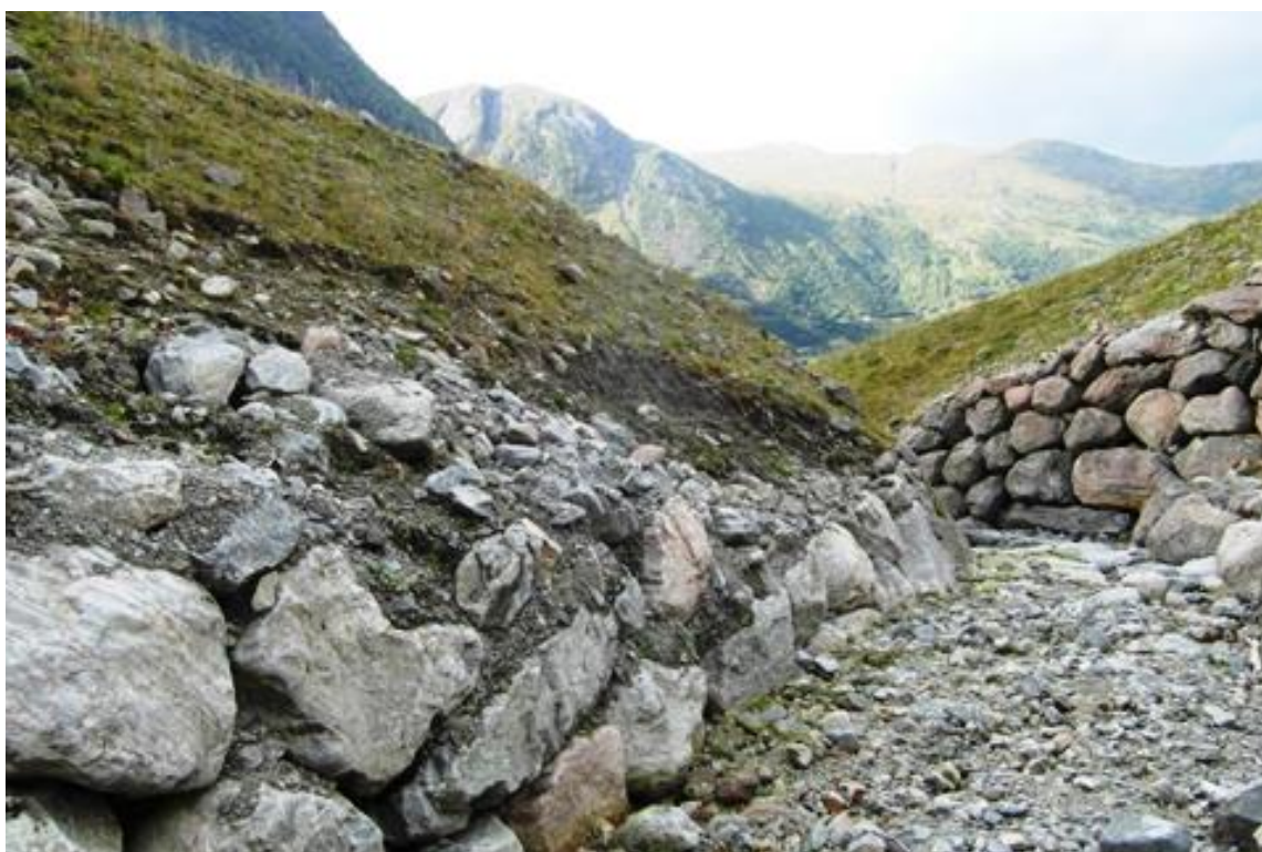
Figur 30: Tørrmuren er for lav, og skred har erodert direkte på løsmassene til Vikanevollen 3 i Kjøsnesfjorden (foto: Feltarbeid 2013).
