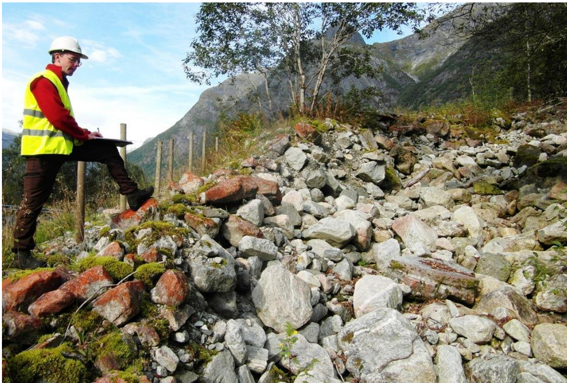
Figur 28: Melandsgjelavollen i Vettefjorddalen har erodert støttside på grunn av skred (foto: Feltnarbeid 2013).
