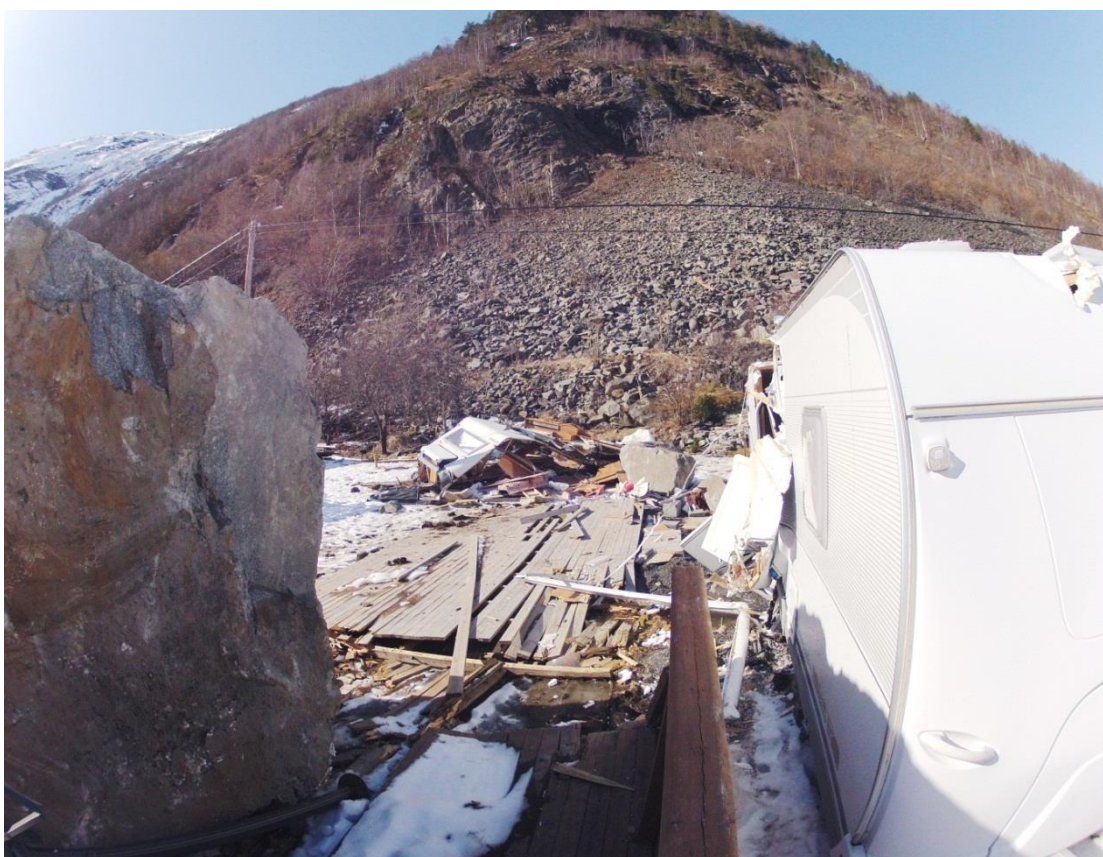
Figur 9: Steinsprang, Tafjord Camping april 2013. Minst ti campingvogner ble skadet. (Foto: Simon Løvås)
