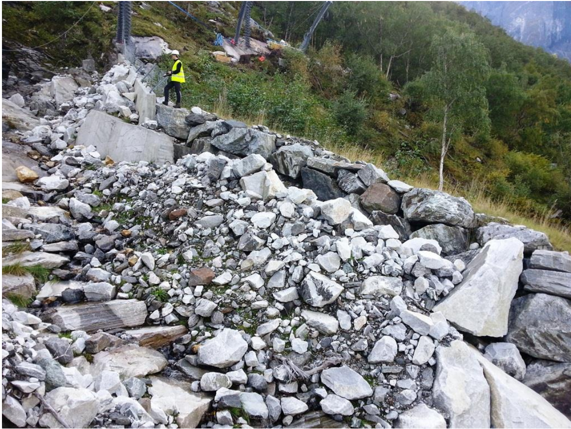
Figur 27: Arvenesvollen i Øvre Årdal har oppfylt skredmagasin (foto: Feltnarbeid 2013.)
