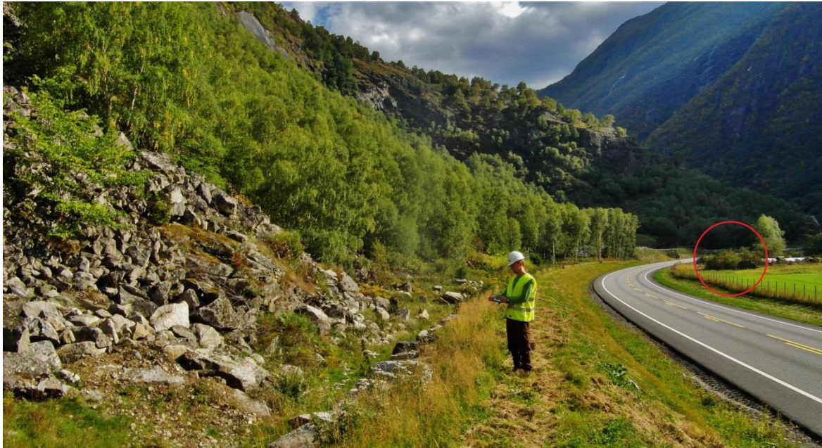
Figur 47: Til venstre i bildet vises utstikker til ur over Storeskorvollen langs E16, Nordre Bjørkum, Lærdalen. Til høyre i bildet i rød sirkel vises eldre utløpsblokker (foto: Feltnarbeid 2013).
