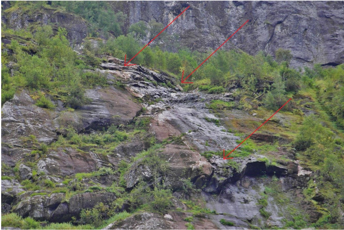
Figur 39: Aktive utløsningspunkt i utløsningsområdet i fjellsiden over Våtedalsvollen (foto: Feltarbeid 2013).
