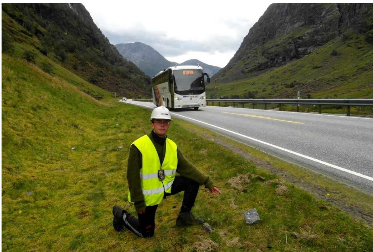
Figur 32: Våtedalsvollen 1 i Våtedalen er for lav. Mange steiner har gått over vollen og stoppet ved veggen, på veggen og på nedsiden av veggen (foto: Feltarbeid 2013).
