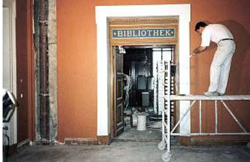
Fra innredningsarbeidet i det nye biblioteket
