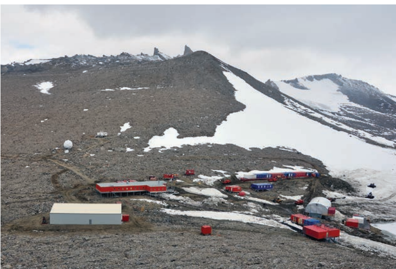
TROLL 2012/TROLL 2012 Oversiktsbilde over Polarinstituttets forskningsstasjon Troll i Antarktis./General view of Troll, the NPI research station in Antarctica. Foto/Photo: Bertran Kiil, NP/NPI
