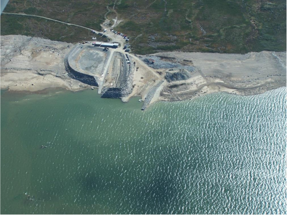
Figur 5. Anleggsarbeider ved Synken i juni 2009 gjorde at vannstanden ble holdt lavt på forsommeren. Dette førte til utvasking av finkorna sedimenter som ga Mår et grønnaktig skjær og førte til betydelig reduksjon i siktedypet.
