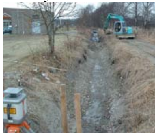
Restaurering av bekken
