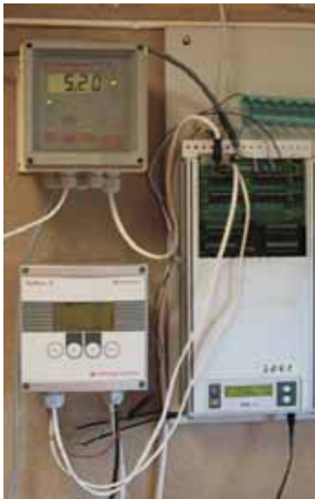
Figur 17. Måleinstrumenter i bu ved bassenget for kontinuerlig registrering av konduktivitet, turbiditet, temperatur og vannføring samt innhenting av vannføringsproporsjonale vannprøver.
