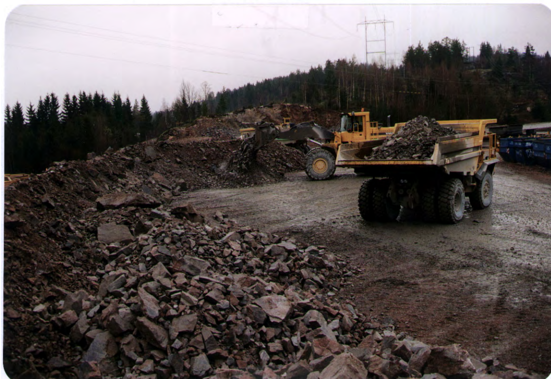
Figur 3. Hver 4. skuffe dumpes i egen haug med topp-påfylling. Resten kjøres vekk.
