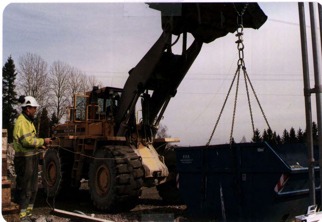
Figur 5. En kontainer med tunnelmasse veies.
