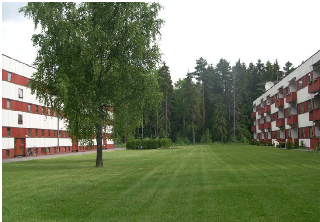
Myhrerenga borettslag, Skedsmo. Foto: Arkitektskap AS
