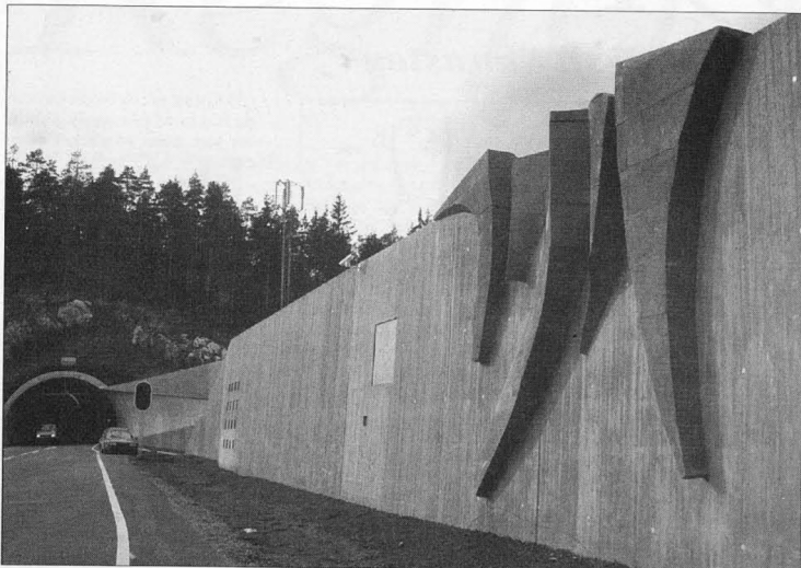
På venstre siden: Vinterbro tunellen, veggdekorasjon.
