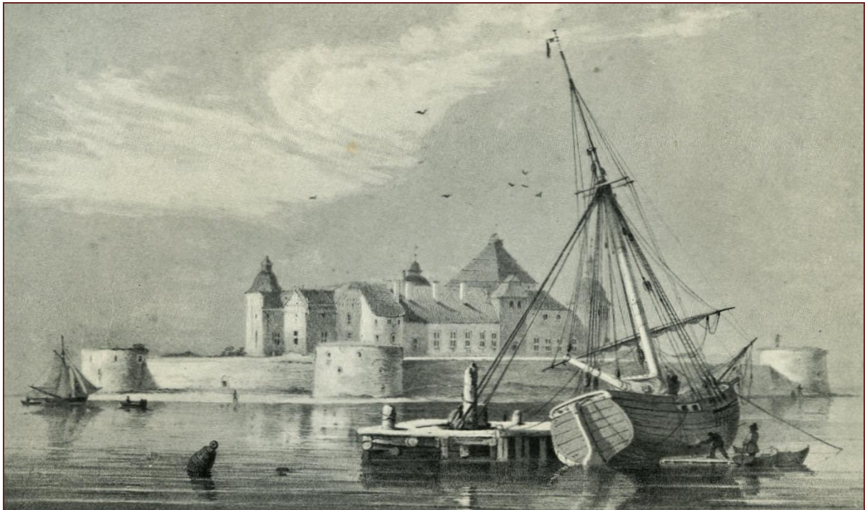
Figur 35. Bildet viser en jakt som blir kalfatrert. Disse typer båter ble også vanlig i Oslofjorden fra ca 1450. Bildet er et litografi av Johan Christian Berger og viser en typisk bolverkskonstruksjon utenfor Kalmar slott. Bildet er datert 1856 (I Åkerlund 1951:26).
