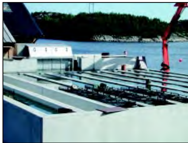
Figur 2 Det nye landanlegget for kamskjellyngel hos Scalpro AS på Rong i Øygarden. The new land-based on-growth facility for scallop spat at Scalpro AS at Rong in Øygarden.
