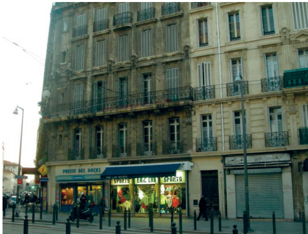
Illustration 23. Renovation in rue de la République.
