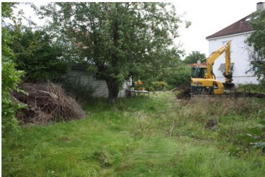
Figur 2:Cf34519_001 Oversiktsbilder over tiltaksområdet før avdekking. Sett mot sørøst
