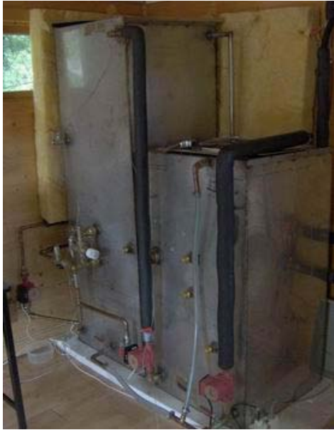
Figur 3.3: Bildet av soltanken og romvarmetanken. Bildet til venstre viser tankene under oppbygging sommer 2006. Nederst på Soltanken vises solpumpen til høyre og utvekslingspumpen til venstre. Bildet til høyre viser de ferdigstilte tankene.
