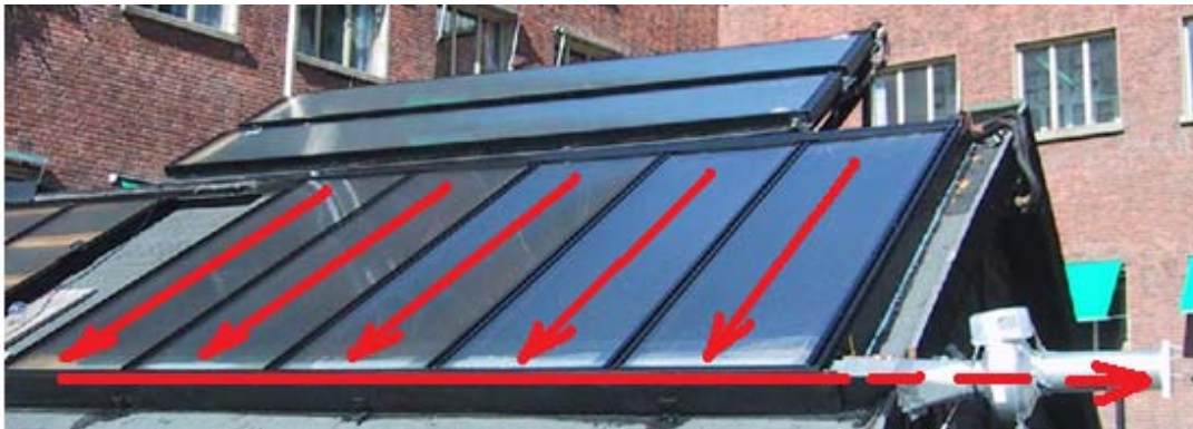
Figur 3. 8: Luftstrømmen gjennom solfangerne ved bruk av vifte på natten under kjøleforsøk.
