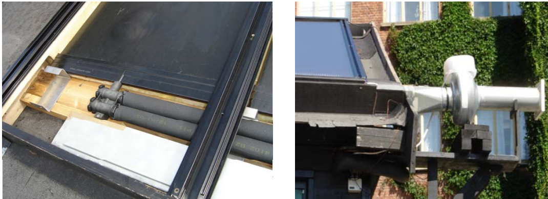
Figur 3. 7: Solfangeren uten dekkplate (til venstre) med innløp og utløp for vannsirkulasjon gjennom absorbatoren. Samlekanalen for luftsirkulasjonen plassert nederst i manifolden. Plassering av sirkulær kanalvifte CK100C (til høyre).
