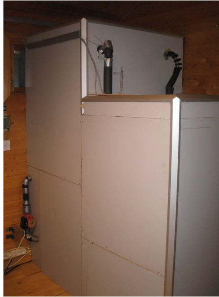
Figur 3.3: Bildet av soltanken og romvarmetanken. Bildet til venstre viser tankene under oppbygging sommer 2006. Nederst på Soltanken vises solpumpen til høyre og utvekslingspumpen til venstre. Bildet til høyre viser de ferdigstilte tankene.
