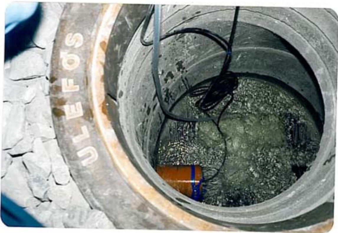
Figur 17. Turbid drens vann under anleggsarbeidet (øverst) og klart drens vann etter avslutningen (nederst).
