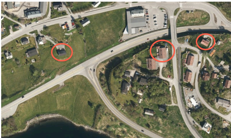
Figure 30: Bygg som trolig må rives.
