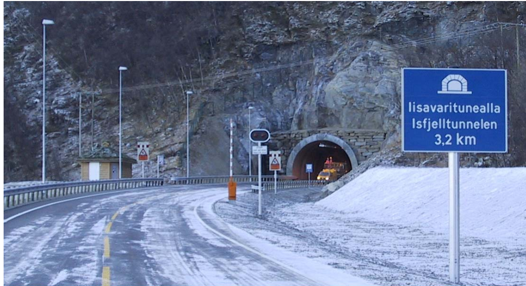
Tunnelåpning ved ny Isfjelltunnel.
