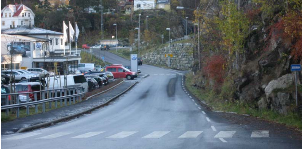
Bilde fra Kilen, kommunal veg 30 km/t, med nytt fortau
