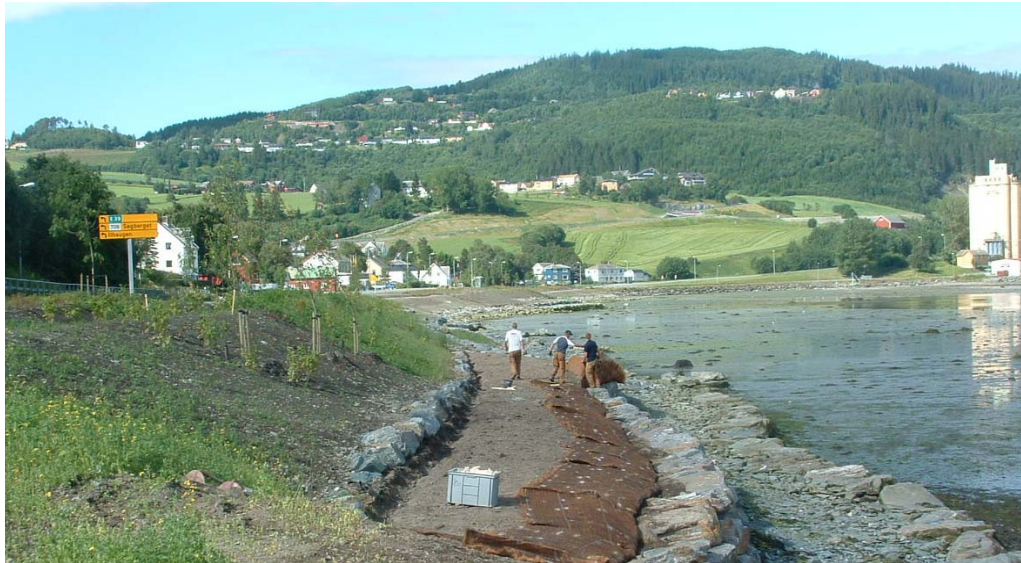
Bygging av gangveg/tursti langs gamle E39 i Buvika.
