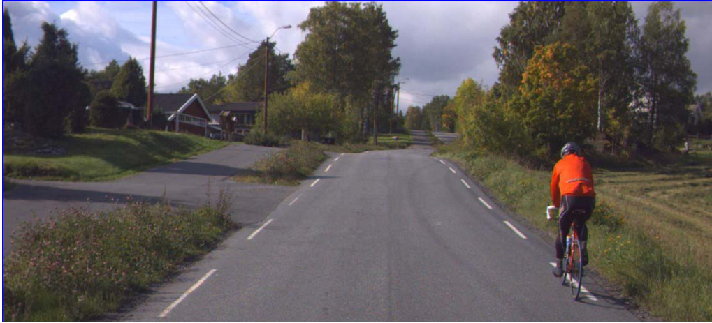
Fv 73 som er den nye tilfartsvegen fra ny E134 til Darbu tettsted. Ny gang-/sykkelveg til venstre.
