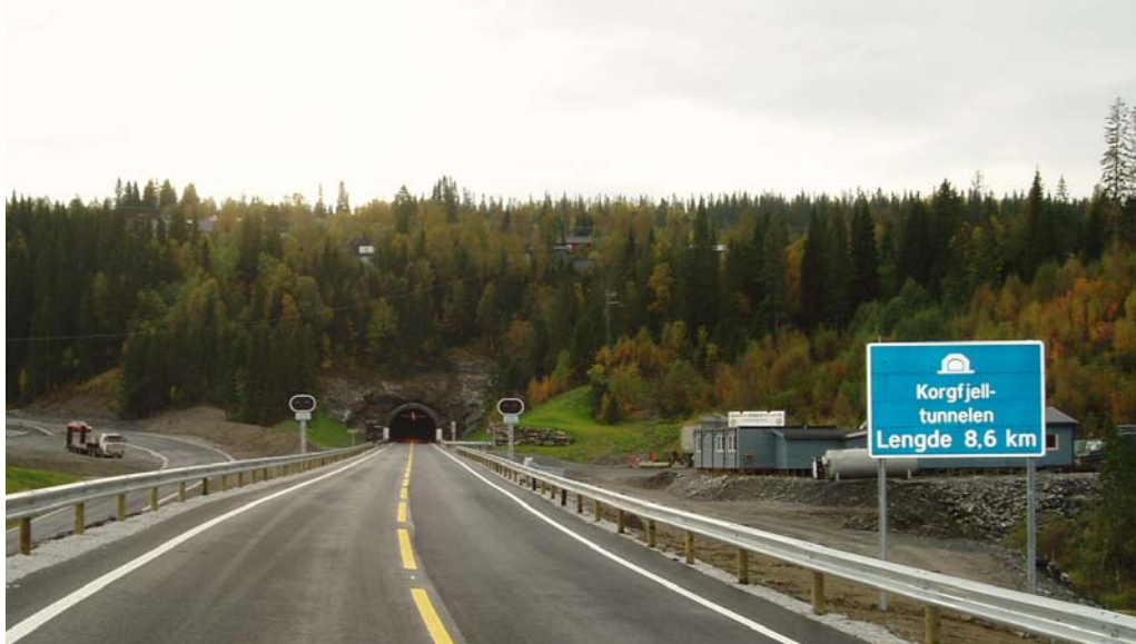
Korgfjelltunnelen , nordre tunnelåpning.
