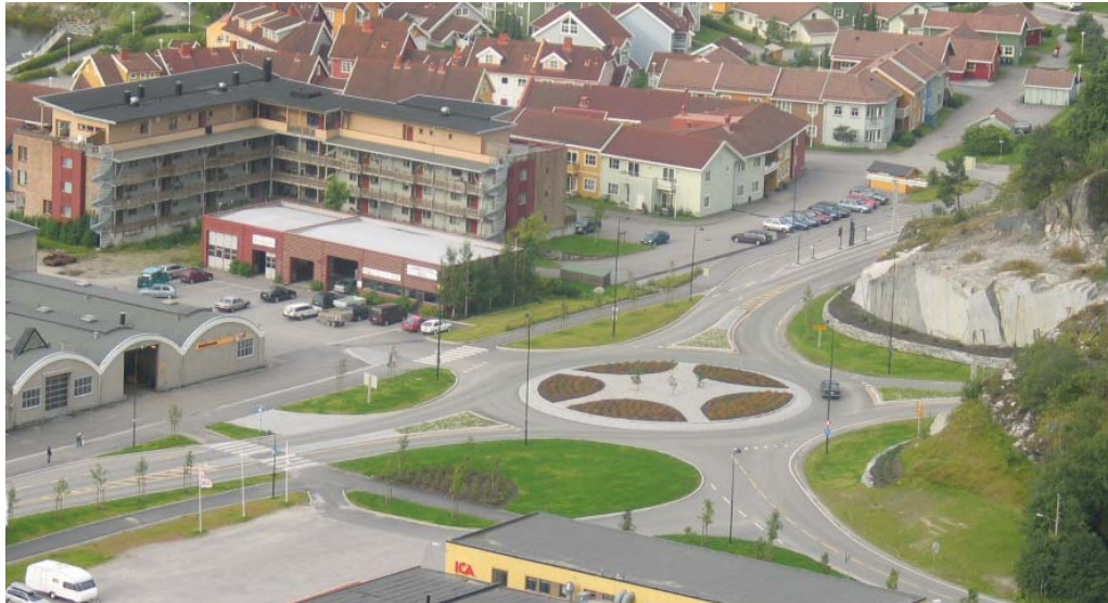
Rundkjøring ved Vika-tunnelen på opprustet rv 769 gjennom Namsos by
