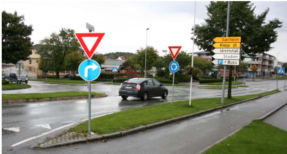
Tidligere riksvegtrase gjennom Kleppe sentrum, med lavere fart og bedre kryssingsmuligheter
