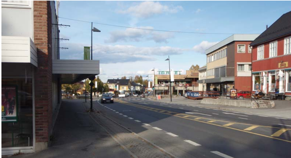
Avlastet veg gjennom Raufoss sentrum
