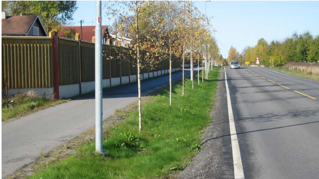
Rv 124 mellom ny E18 og rv128. Ny gangveg og støyskjermer
