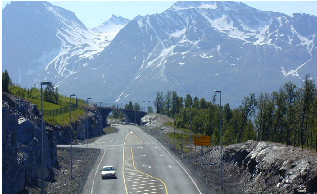
Ny E8 i kryss med fv 292, ved Seljelvnes.
