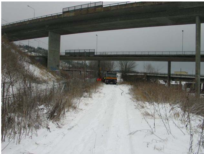
Bilde 7 er tatt under eksisterende E18 på Farriseidet. Sammen med de to lokalvegene vises det første treplanskrysset i Norge. Grunnundersøkelsene ble foretatt som totalsonderinger til stor dybde, men ingen sonderinger kom ned til fjell. Foto: Bjørn Dolva
