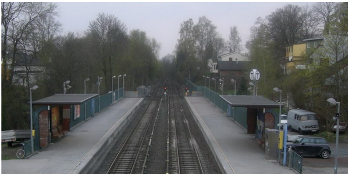
Figur 5.1 Oversiktsbilde fra Blindern undergrunnsstasjon.
